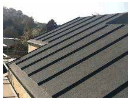
Eksempel på tagpaptag med trekantlister
