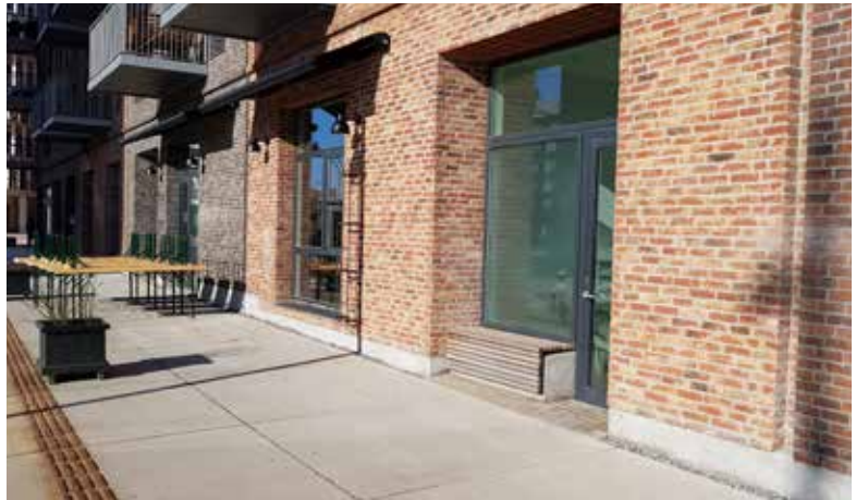
Tilbagetrukne partier i facaden kan anvendes til ophold og små hvil i byrummet
