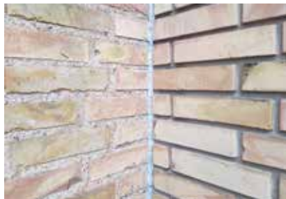
Blødstrøgne sten, til venstre i billedet, giver et levende, rustikt facadeudtryk frem for maskinsten, som ses til højre
