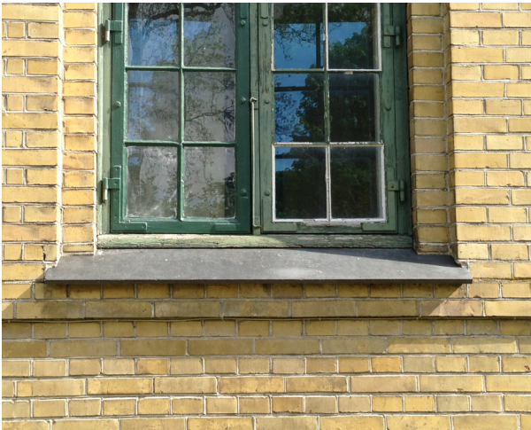
Enkle detaljer i murværket omkring vinduer og sålbænke i skifer.
