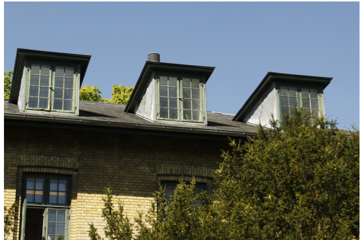
Karakteristiske kviste på bygningen østside.
