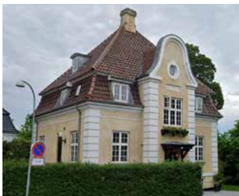
Fig. 16. Herskabsvilla i nybarokstil. Indgangspartiet i træ, med kobberdækning
