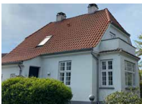
Fig.18. Huset er inspireret af bedre byggeskik-stilen med sit rationelle upyntede udtryk
