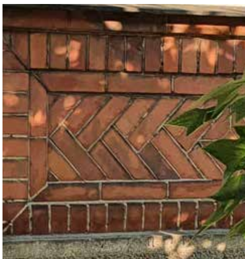
Fig. 13. Mønstermurværk med maskinsten. Med diagonalt indmurede teglsten opnås en rustik reliefvirkning
