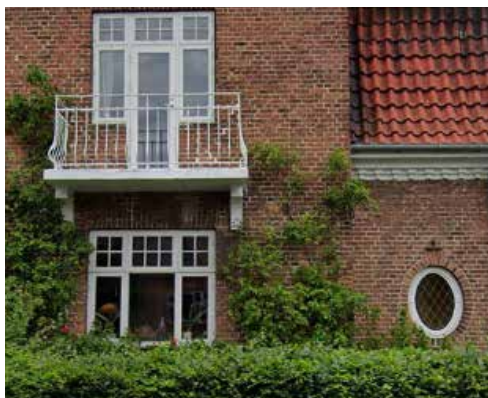
Fig.20. Støbejernsdetaljer i form af blyindfattede ruder og rækværk om altan ses bl.a. på Skovbovængets Alle 28.
