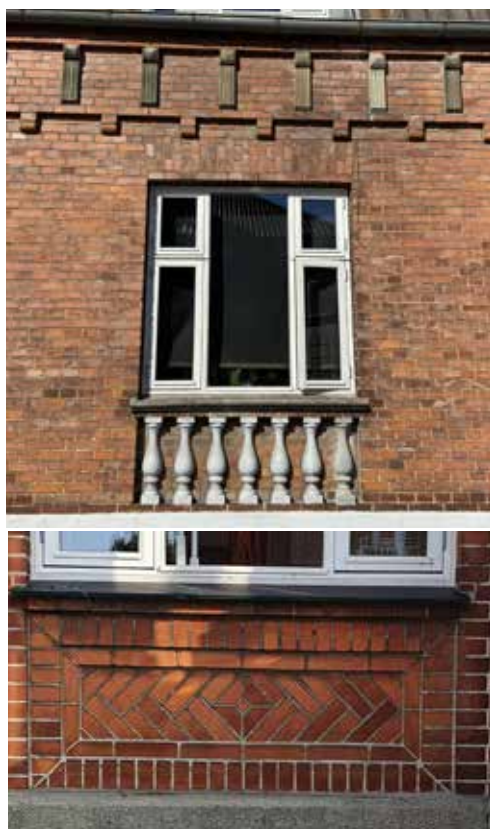
Fig.31. Ornamentik i facaden, som fx stik ved vinduer og døre, friser og stuk, skal bevares eller erstattes med tilsvarende kopier ved slitage
