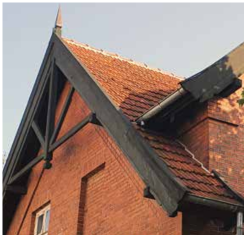
Fig. 11. Tagudhængt med ornamentale udskæringer og gavludsmykning er typisk for murede villaer i schweitzerstil
