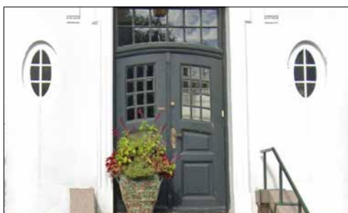
Fig.19. Eksempel på fyldningsdør på Skovbovængets Alle 4.
