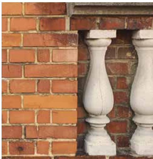
Fig. 12. Murværket er ofte glatte maskinsten med kelet fuge eller tilbagetrækket fuge og facadeudsmykningen kan f.eks. være balustre støbt i beton
