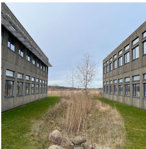
Fig.2. Kig mellem bygninger til Ådalen © PLH arkitekter
