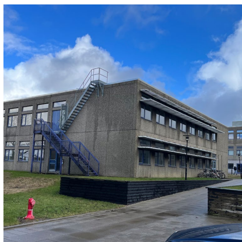
Fig.6. Bygning 19, eksisterende udvendig flugttrappe og adgang til tag © PLH arkitekter
