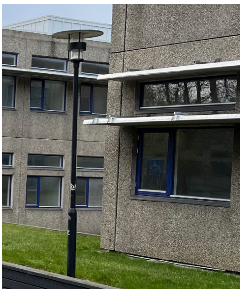
Fig.12. Eksisterende belysningsarmatur langs vej © PLH arkitekter
