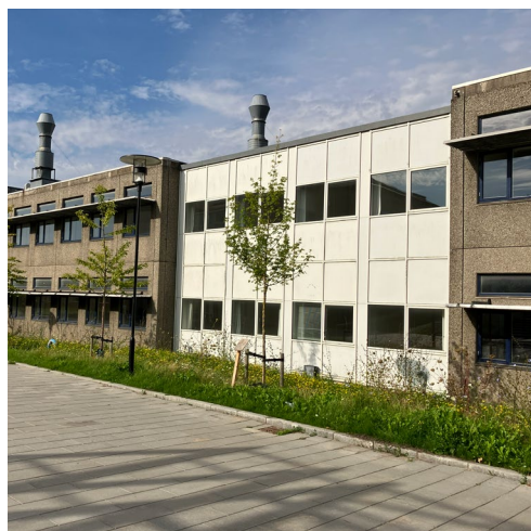
Fig.5. Bygning 17 og 18 er forbundet med en let mellembygning. © PLH arkitekter © SDFE, Roskilde Kommune
