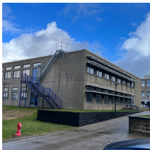
Fig.6. Bygning 19, eksisterende udvendig flugttårn og adgang til tag © PLH arkitekter
