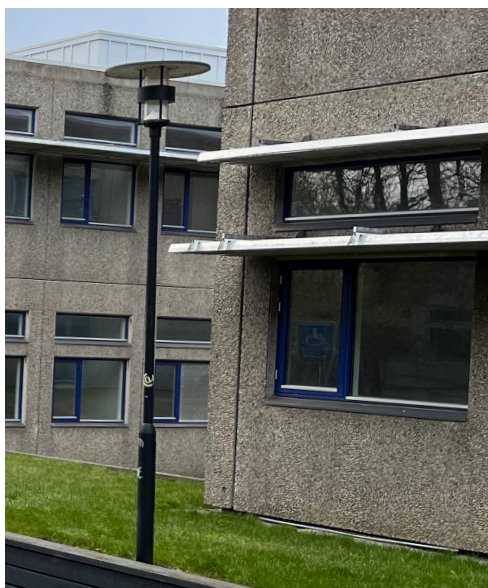
Fig.12. Eksisterende belysningsarmatur langs vej © PLH arkitekter
