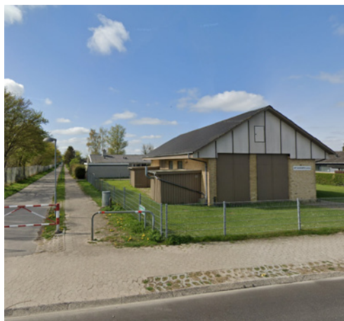
Fig.3. Foto af Viby Vandværk og nærliggende gang- og cykelsti. © Google Maps
