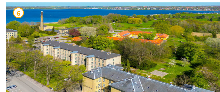
Skt. Hans Vest er blevet separatkloakeret
