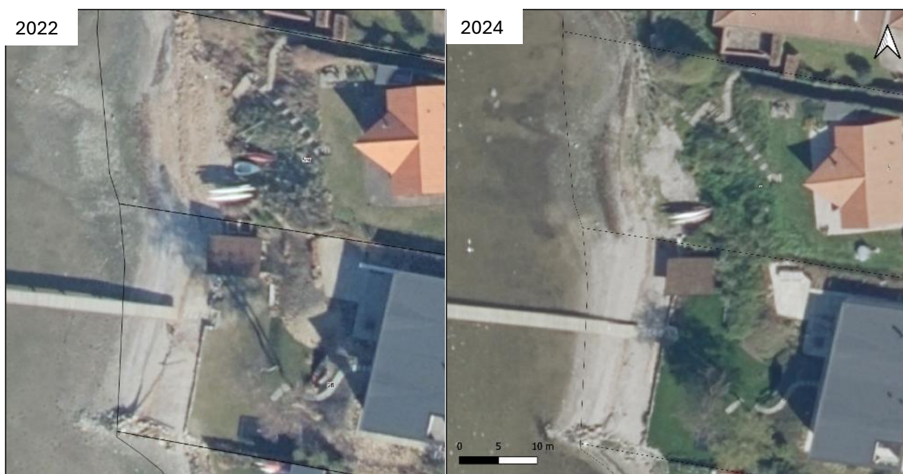
Figur 4.12: Frederiksborgvej 105B og 105C, erosion af skrænten efter stormen Pia i december 2022.
