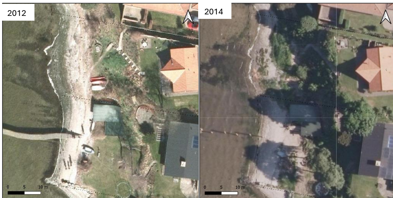
Figur 4.11: Frederiksborgvej 105b og 105C, erosion af skrænten efter stormen Bodil i december 2013.
