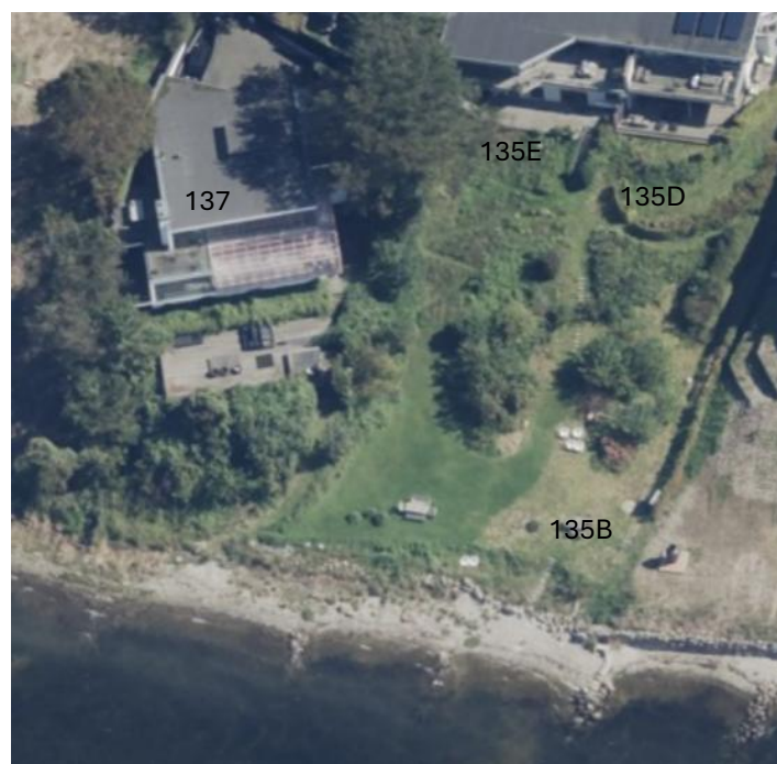
Figur 4.27: Frederiksborgvej 135B, 135D, 135E og 137, kystbeskyttelse i form af mindre skråningsbeskyttelse. Skråfoto 2023.
