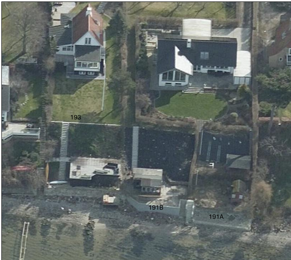
Figur 4.46: Frederiksborgvej 191A, 191B, 193, kystbeskyttelse i form af mur, samt tilretning af skrænt med stabiliserende dug, skråfoto fra 2017.
