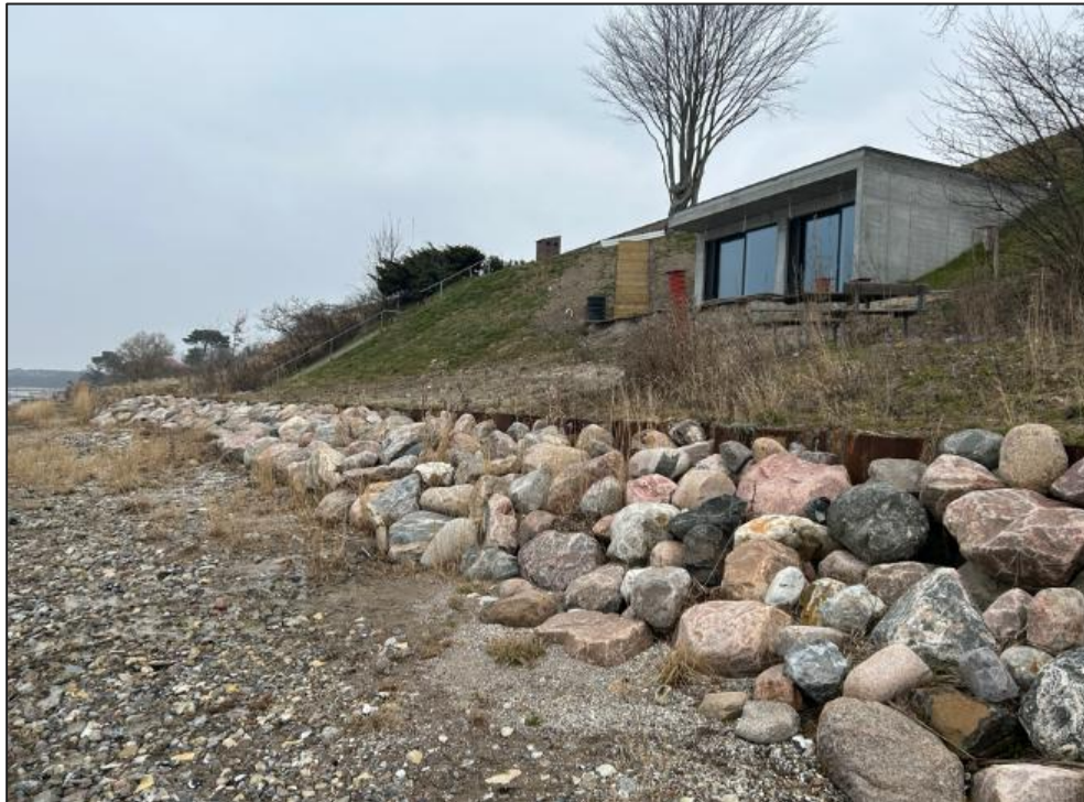
Figur 4.35: Frederiksborgvej 139 og 141, skråningsbeskyttelse samt spunsvæg og nyt bygget hus/anneks
