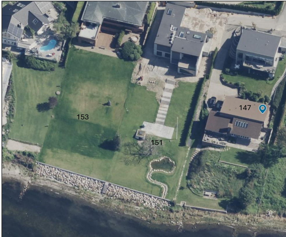
Figur 4.36: Frederiksborgvej 147, 151 og 153, mur foran alle tre grunde, samt skråningsbeskyttelse foran nr 151 og 153. Skråfoto 2023.
