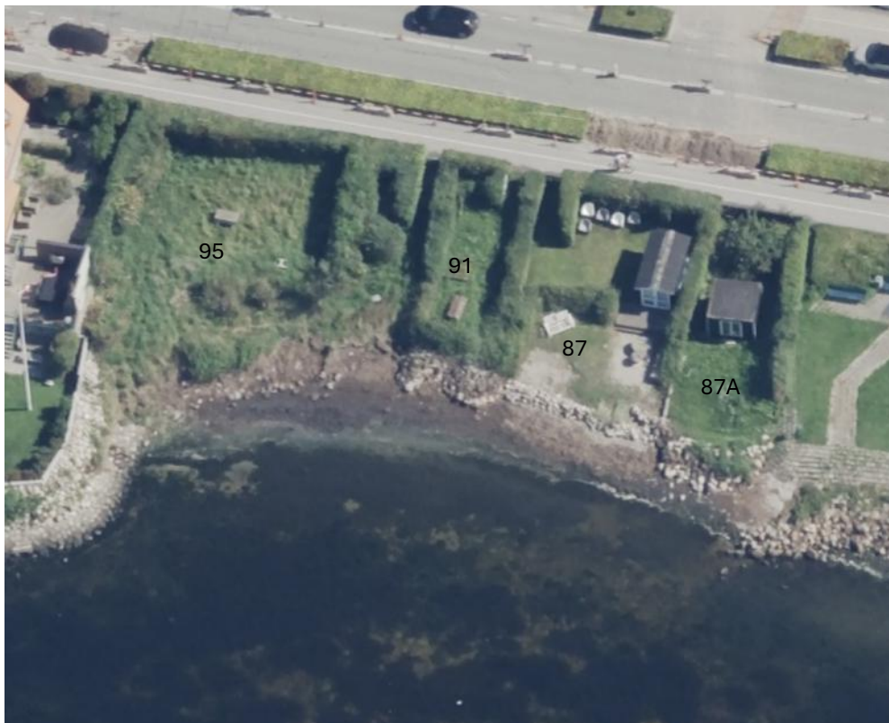
Figur 4.1: Frederiksborgvej 87A, 87,91 og 95. Kystbeskyttelse i form af mindre skråningsbeskyttelse. Skråfoto 2023.
