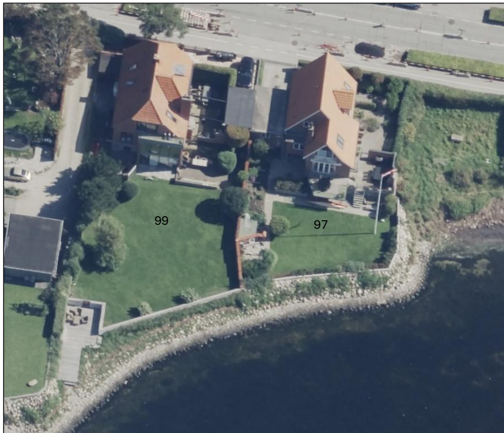
Figur 4.4: Frederiksborgvej 97 og 99, Kystbeskyttelse i form af skråningsbeskyttelse og mur. Skråfoto 2023.
