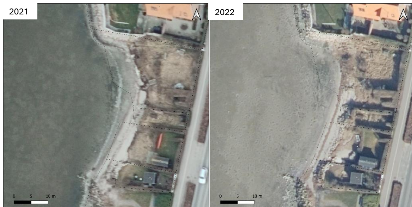
Figur 4.2: Frederiksborgvej 87A, 87, 91 og 95, erosion af skrænten efter stormen Malik i januar 2022.
