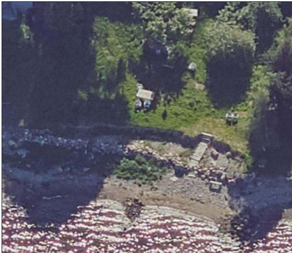
Figur 4.30: Frederiksborgvej 135C, 135D og 135E, som hjørnet af 137, erosion af skrænt bagved stenkastning. Skråfoto 2019.
