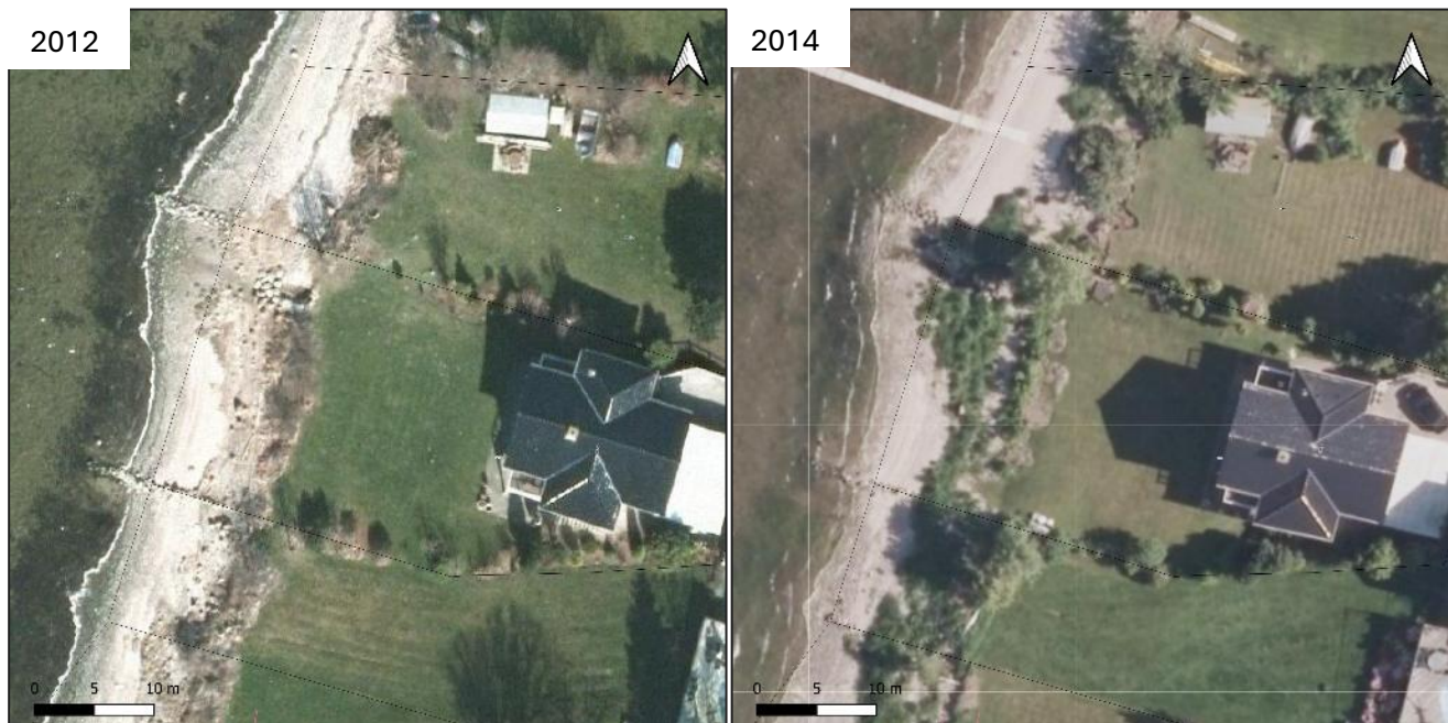
Figur 4.39: Frederiksborgvej 155A, 155B og 165A, erosion af skrænten efter stormen Bodil i 2013.
