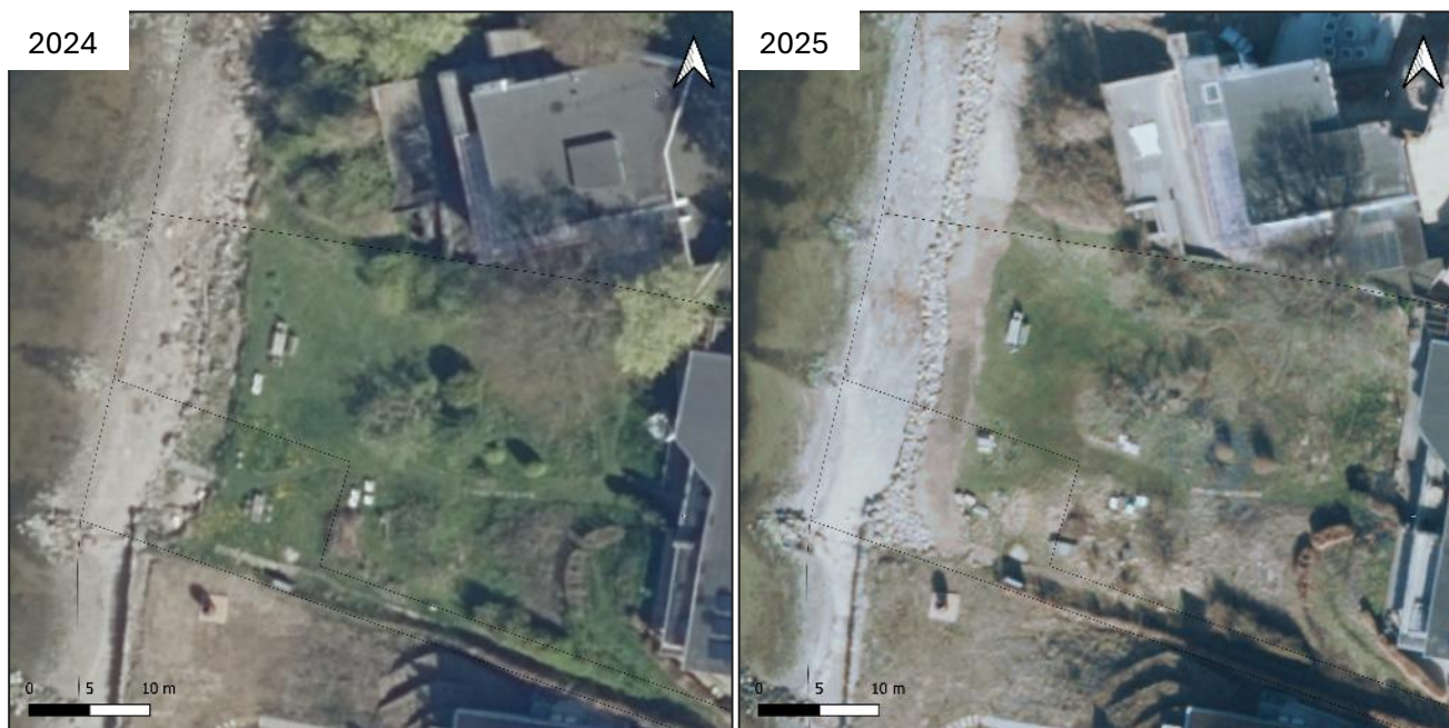
Figur 4.31: Frederiksborgvej 135C, 135D og 135E, erosion af skrænt i december 2023 og efterfølgende reetablering af skrænt med skråningsbeskyttelse i december 2024.
