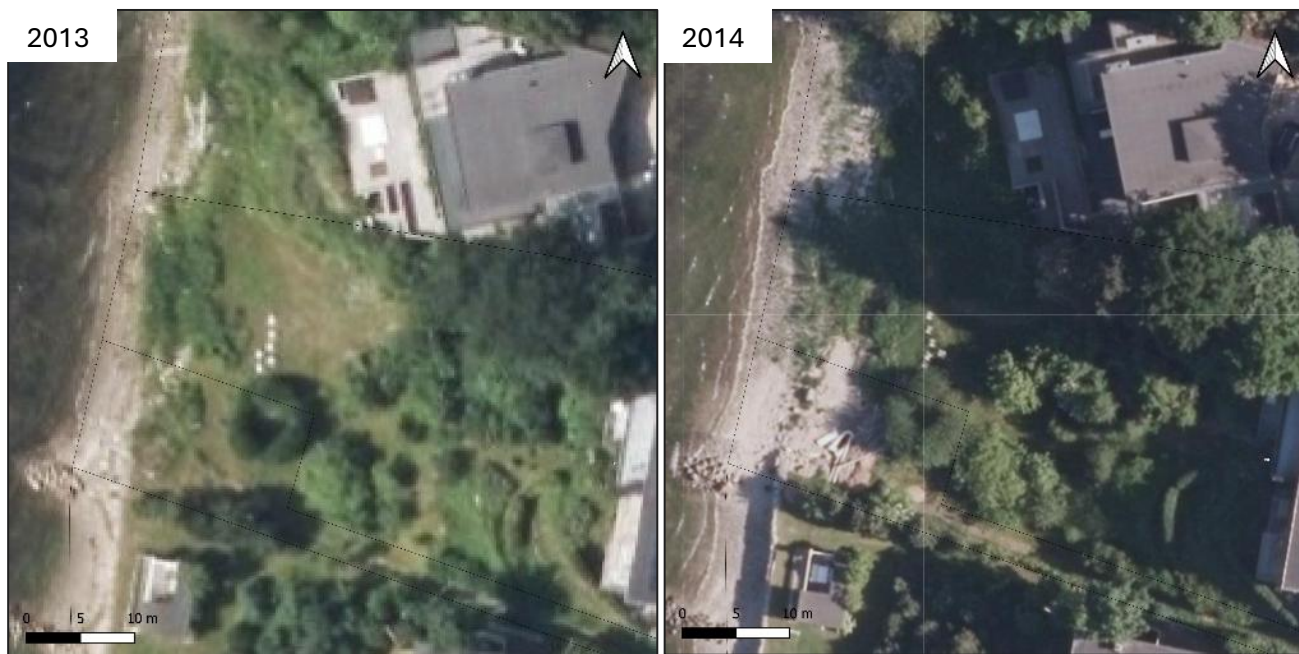
Figur 4.28: Frederiksborgvej 135B, 135D og 135E, erosion af skrænten efter stormen Bodil i 2013.
