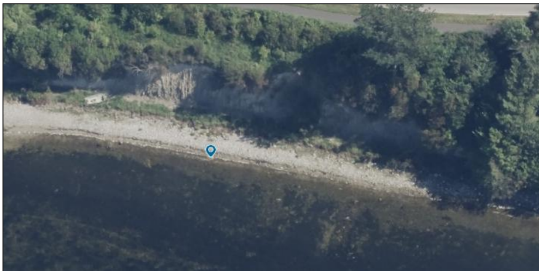
Figur 2.4: Strækning nord for Frederiksborgvej 205 hvor de lokale forhold ikke er karakteristiske for en tilgroningskyst, som Kystdirektoratet har klassificeret den. Forholdene minder mere om en klintekyst uden klitter eller en blød klintekyst. Skråfoto taget i 2023. (Dataforsyning, 2026).
