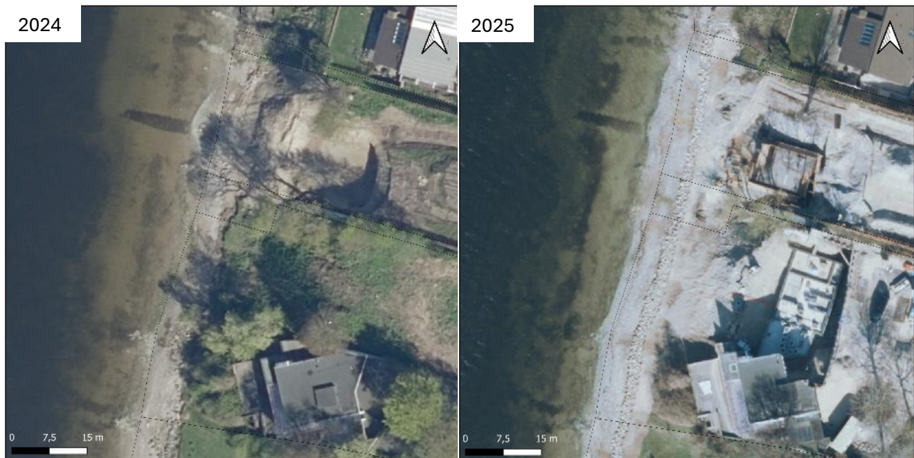
Figur 4.34: Frederiksborgvej 137, 137B, 139 og 141, erosion af skrænt i 2024 og efterfølgende reetablering af skrænt med skråningsbeskyttelse 2025.
