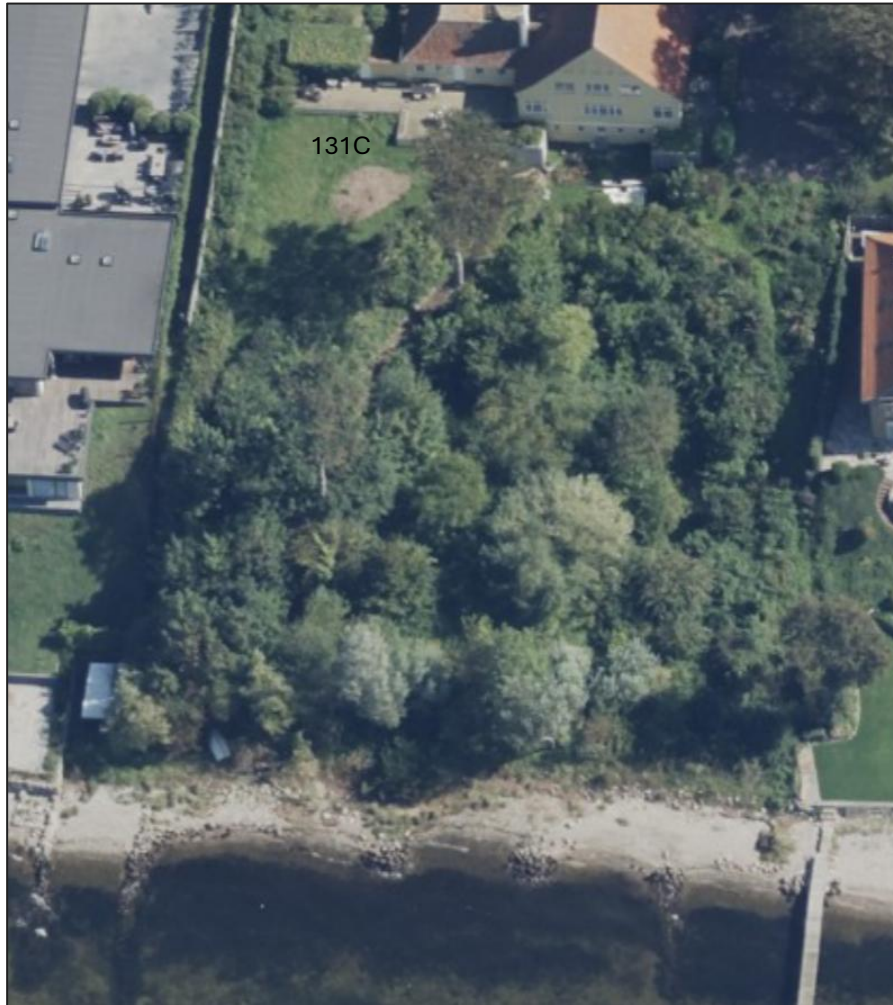
Figur 4.23: Frederiksborgvej 131C, kystbeskyttelse i form af hølfer. Skråfoto 2023.
