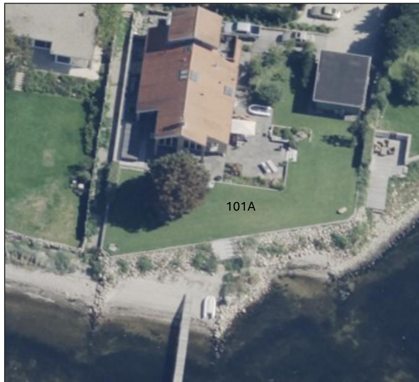
Figur 4.5: Frederiksborgvej 101A, Kystbeskyttelse i form af skråningsbeskyttelse og mur. Skråfoto 2023.
