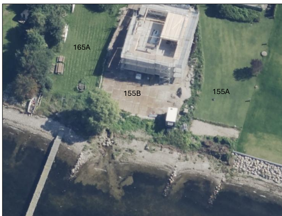
Figur 4.38: Frederiksborgvej 155A, 155B og 165A, ingen kystbeskyttelse. Skråfoto 2023.
