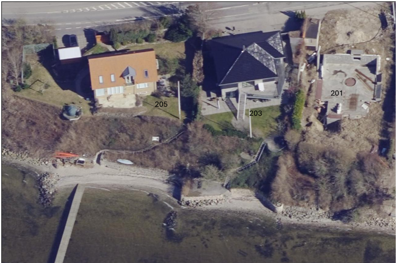
Figur 4.50: Frederiksborgvej 201, 203 og 205, kystbeskyttelse i form af skråningsbeskyttelse og mur, skråfoto fra 2021
