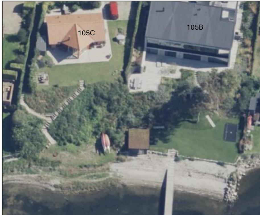
Figur 4.10: Frederiksborgvej 105B kystbeskyttelse i form af en mur og frederiksborgvej 105C ligger ubeskyttet, skråfoto 2023.
