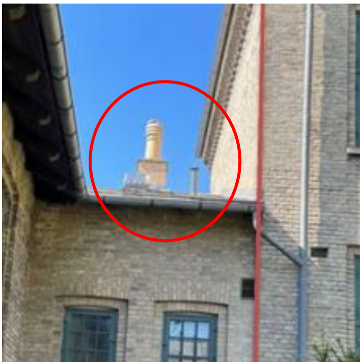
Figur 8: Gennemføringer i tagfladen i mellembygningen.
