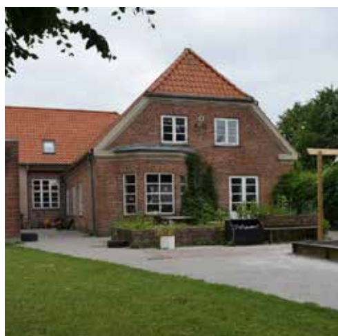
Fig.12. Billedet viser vestgavlen på sydføljen, som udgør en del af den bevaringsværdige bebyggelse, som ikke må nedrives
