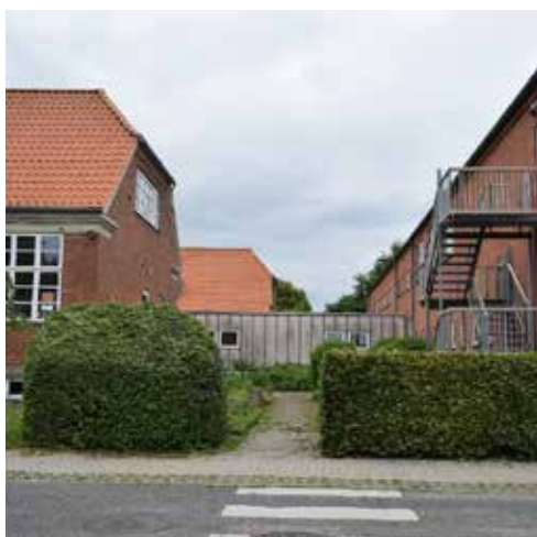
Fig.5. Adgang til gården med sydføljen til venstre og administrationsbygningen til højre
