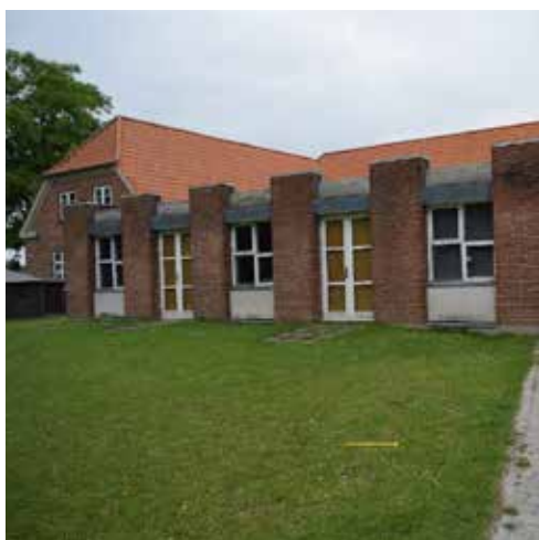
Fig.6. Mellem nord- og sydføljen fra 1914, mod Vibygårdsvej, ligger en nyere tilbygning, som med lokalplanen erstattes af en ny bygning.
