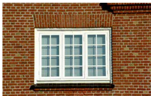
Fig.18. Eksempel på muret, lige stik over vindue.
