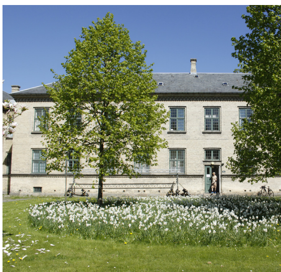
Kurhus Bygning 28 set fra syd
