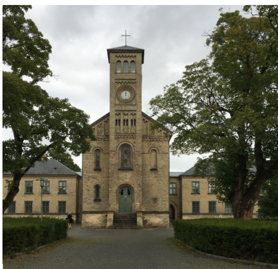
Kurhus Bygning 27 set fra syd
