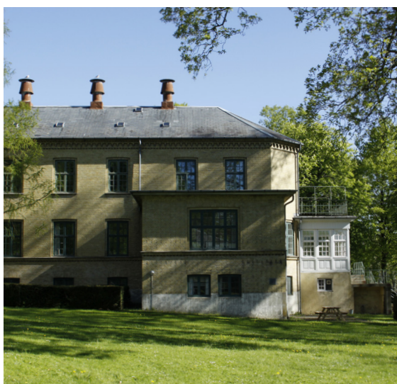
Kurhus Bygning 24 set fra syd
