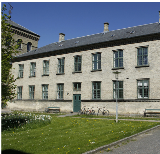
Kurhus Bygning 25 set fra syd
