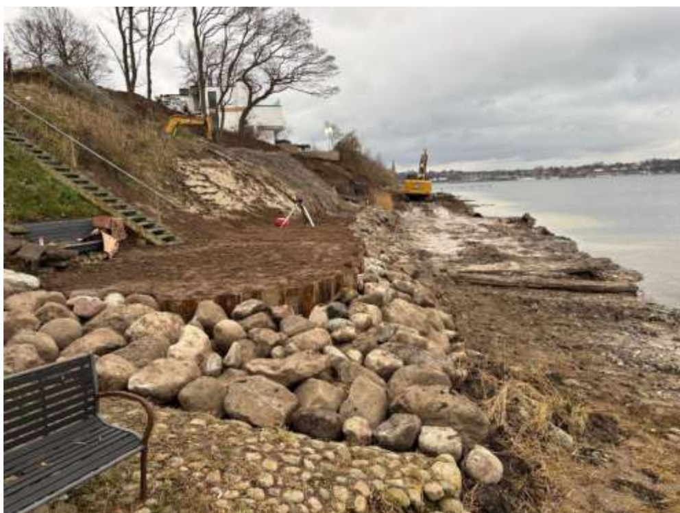
Det etablerede anlæg som er ved at blive etableret, foto taget af ansøger, december 2024
