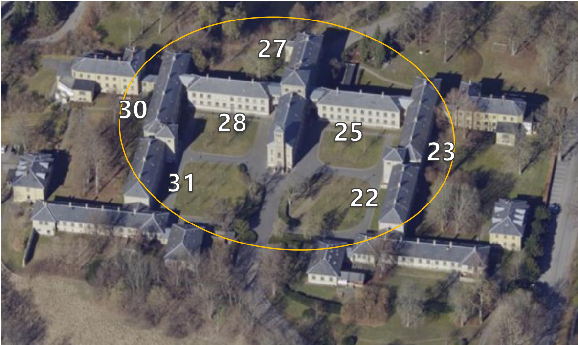
Figur 2.1: Luftfoto over Kurhus med markering af bygningerne
