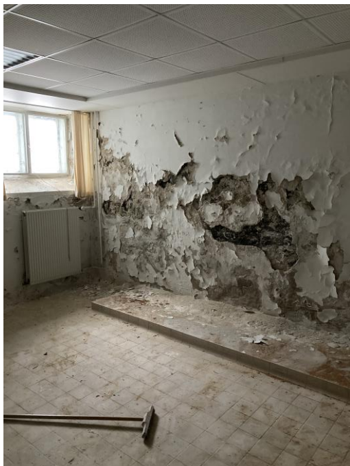
Figur 3.2: Rum til fremtidig varmecentral.
