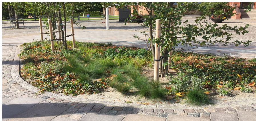
Eksempel på nedsivningsanlæg i Ringsted By.
