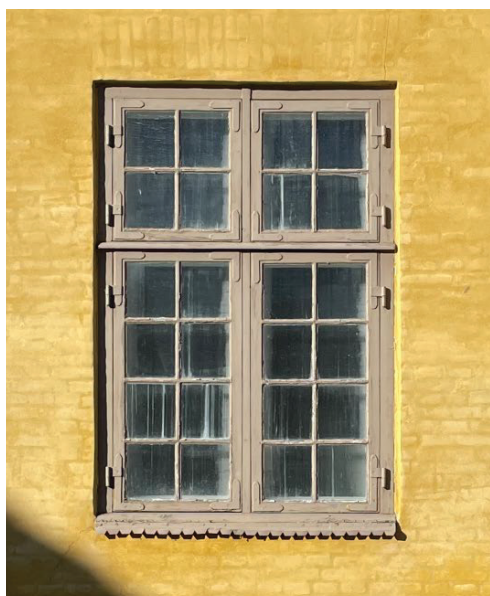
Fig.21. Her ses eksisterende korspostvindue med hjørnebåndshængsel, sprosser med kitfals. Karakteristiske sålbænke i zink med klippet blondekant. © Peter Kjær Arkitekter
