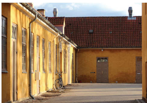
Fig.26. Her ses de eksisterende tag- og nedløbsrønder i zink. I Østlængens sydfacade ses nye ventilationsudtag i tagfladen som skal nedrives og erstattes af skorstene som oprindeligt. © Per Lund
