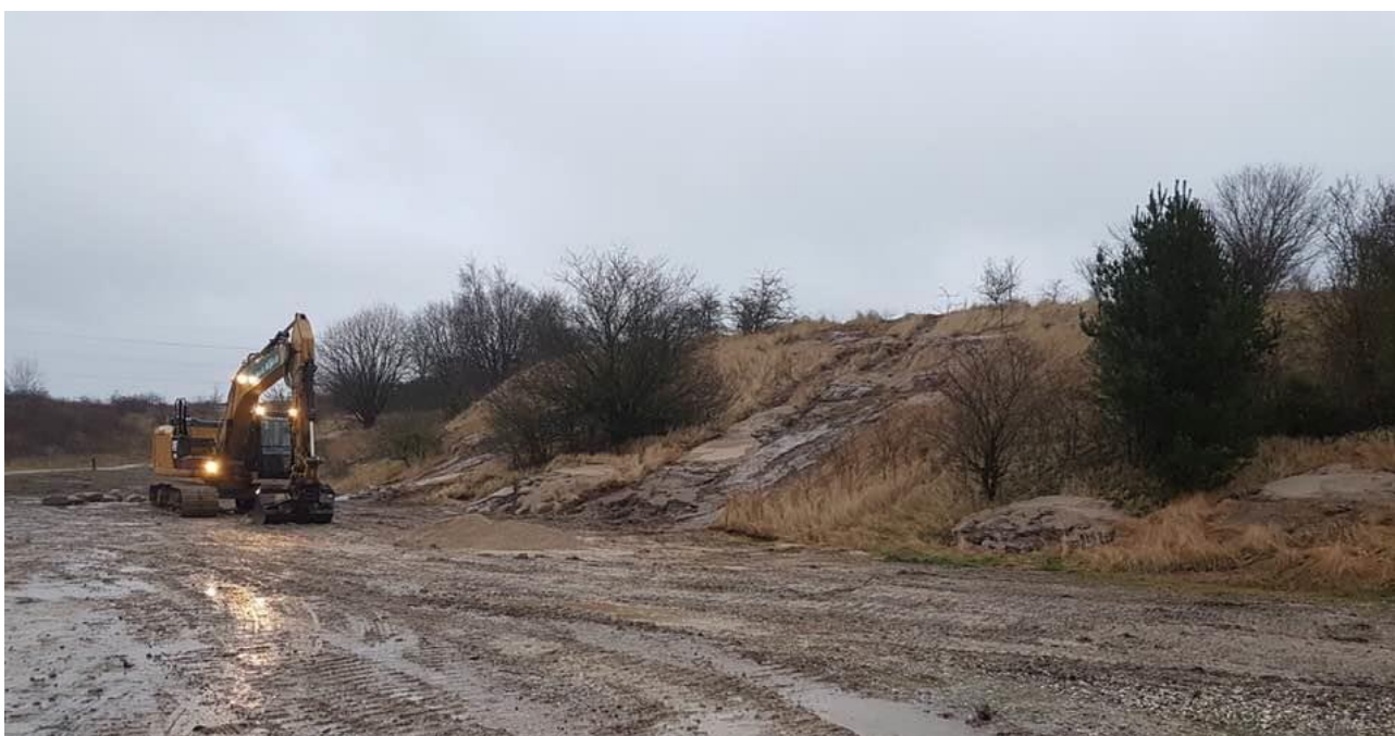
Udlægning af sten- og grusbunker på markfirbenlokaliteten i Darup, december 2017.
