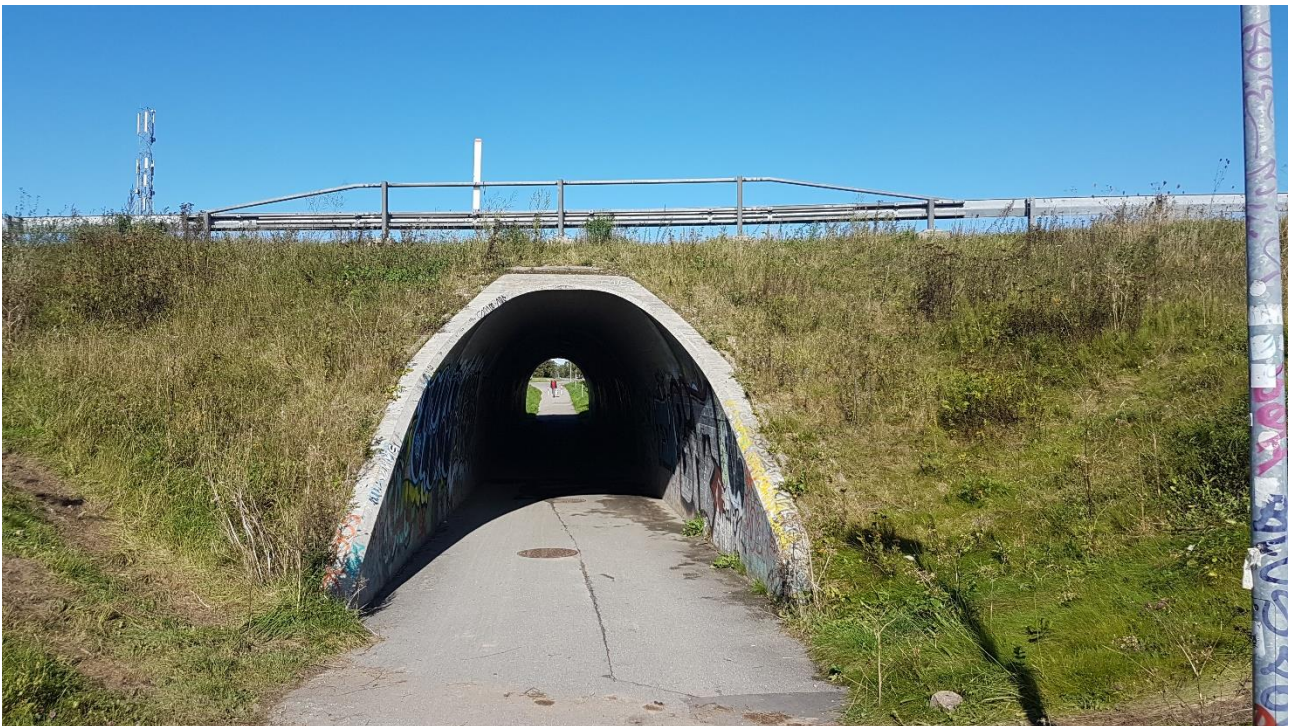
Lokalitet 9: Cykelviadukt under Holbækmotorvejen mellem Bakkeleddet og Darupvej. Yngle- og levested for markfirben.
