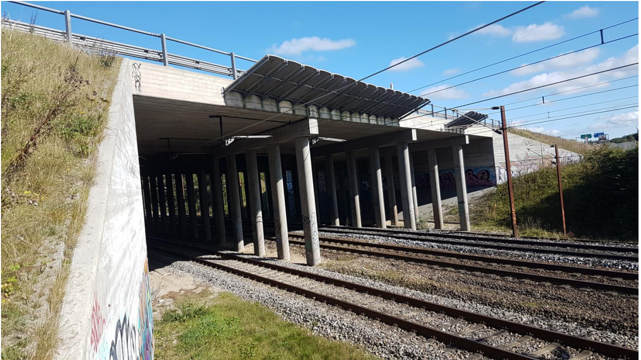
Lokalitet 8: Motorvejsbro ved jernbanetracèet mod vest. Yngle- og levested for markfirben.
