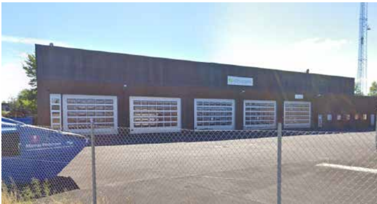
Fig.3. Eksisterende hal på ejendommen, som ønskes genbrugt. © Google Streetview
