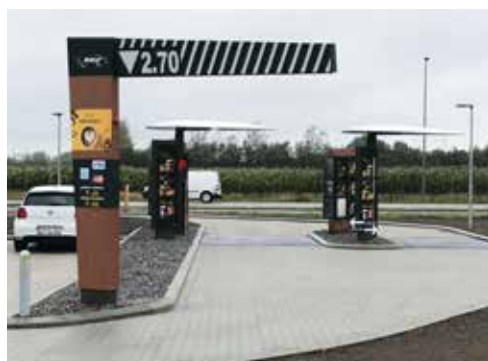
Fig.16. Port, overdækning og reklameskilte i forbindelse med fastfoodrestaurantens drive-in.
