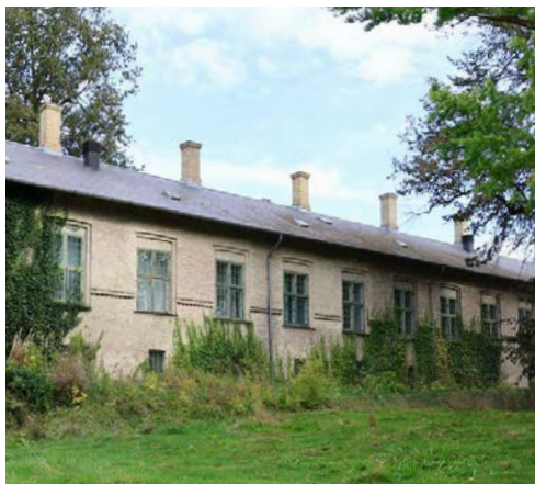
Fig.20. Sydfacaden af Bygning 32 - her ses udformning og detaljering af eksisterende vinduer. © ERIK arkitekter
