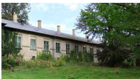
Fig.6. Bygning 32 © SDFE, Roskilde Kommune
