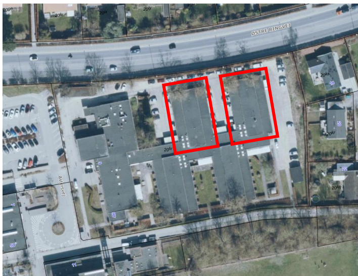
Figur 1: Luftfoto med rød markering af de to bygningsfløje der omdannes
