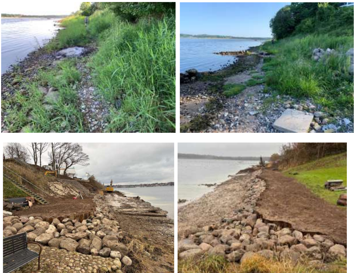
Figur 2 Øverst kysten ud for Frederiksborgvej 137 (tv) og Frederiksborgvej 135d (th), sommer 2021 og nederste fotos er taget i etableringsfasen december 2024
