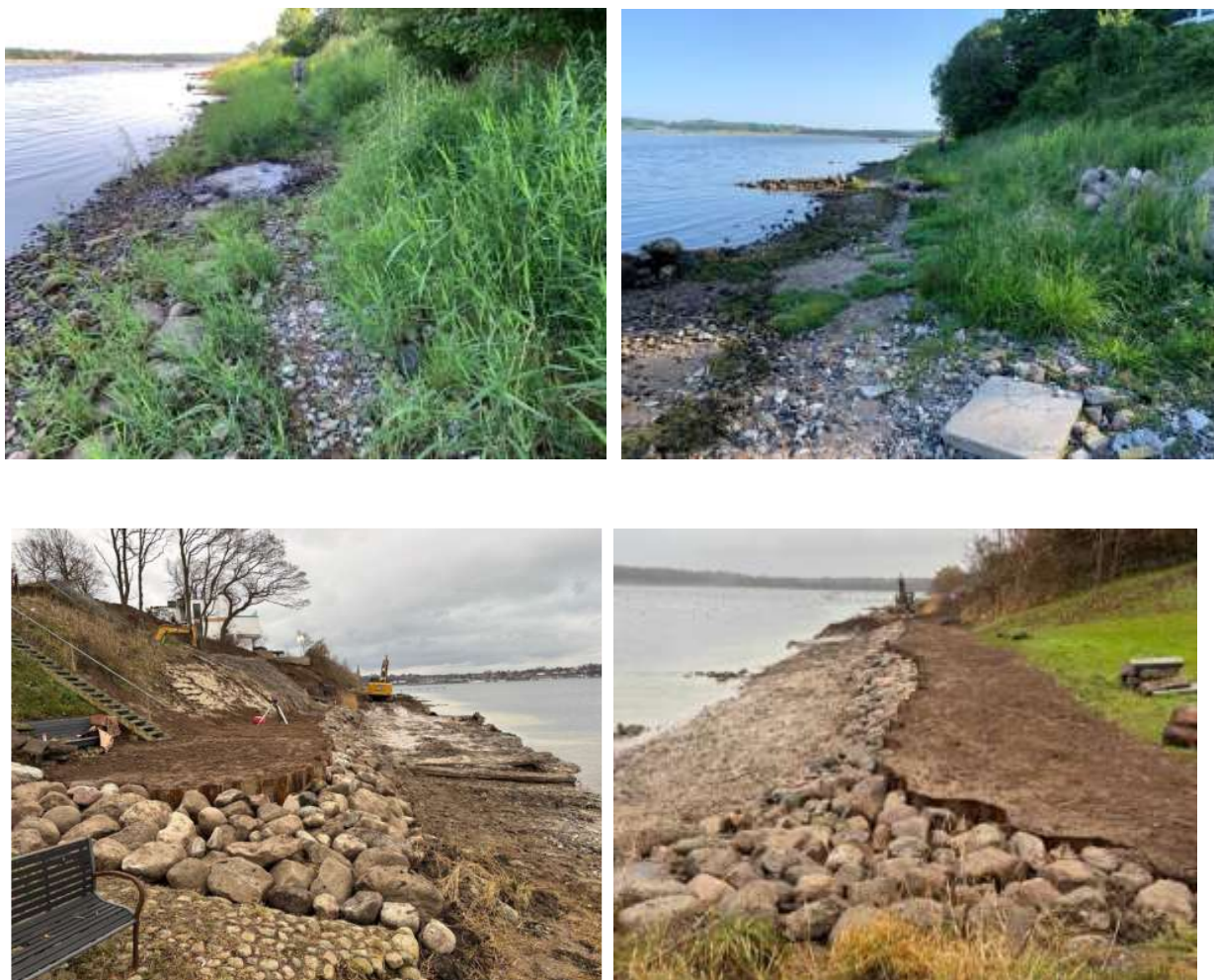
Figur 2 Øverst kysten ud for Frederiksborgvej 137 (tv) og Frederiksborgvej 135d (th), sommer 2021 og nederste fotos er taget i etableringsfasen december 2024
