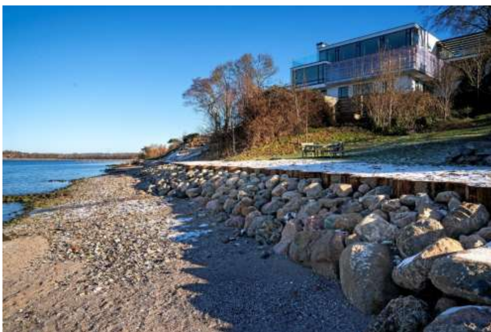
Det etablerede anlæg, januar 2025
