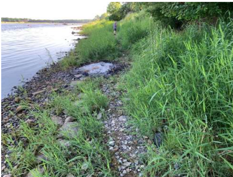
Kysten ved Frederiksborgvej 137, sommer 2021
