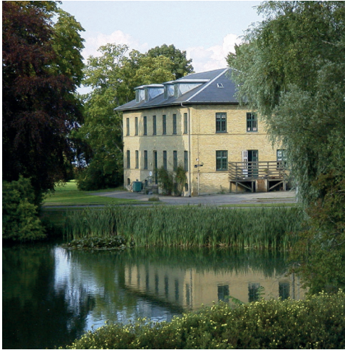
Fig.9. Nørrehus er placeret smukt ved Kurhussøen. Billedet er taget fra den modsatte side ved Kurhus. © SDFE, Roskilde Kommune
