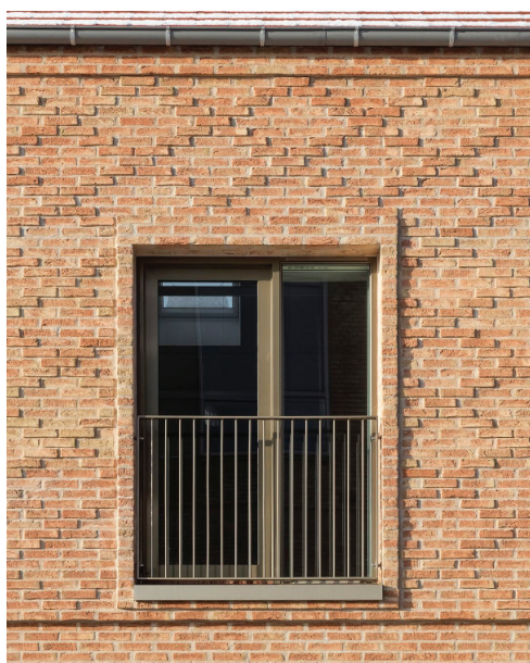
Fig.19. Eksempler på indrammet vinduesparti med murret tegl kant. © Realdania By & Byg/Lars Gundersen
