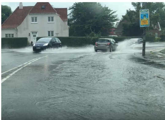
Kong Valdemarsvej fungerer delvist som en skybrudsvej i dag. Selv om meget regnvand naturligt afstrømmer på terræn, presses vand blandet med spildevand op af kloakken.
