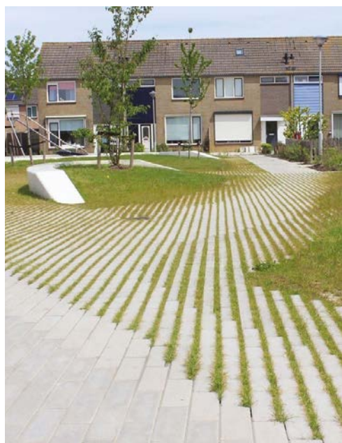
Fig.13. Eksempel på kombination af belægningssten og græsarmering med indsnævninger og flydende overgange. © Bosch Slabbers.
