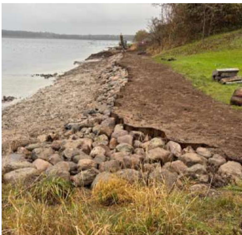
Det etablerede anlæg som er ved at blive etableret, foto taget af ansøger, december 2024
