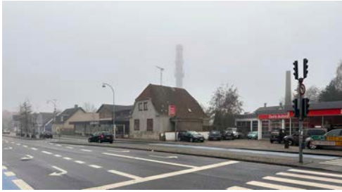
Fig.3. Lokalanområdet ved lokalplanens udarbejdelse. I forgrunden ses Ringstedgade. Mod højre ses autoværkstedet og længere ned ad gaden ses boliger og butikslokaler på Ringstedgade 44-48. I baggrunden ses skorstenen på Fors' varmecentral og en muret skorsten på Ringstedgade 44. Bebyggelsen er opført i højst 1,5 etage. Der er få haver men en stor del af de ubebyggede arealer er belagte og uden særlig beplantning. © Roskilde Kommune.
