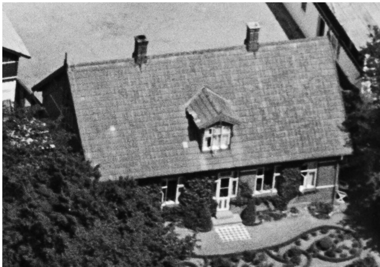
Fig.15. Historisk foto af Ny Højagergårds stuehus set fra syd. Her ses falstag og oprindelige vinduer og terrassedøre med opsprosnings og detaljering. Haven ses også med barokke træer. © Historiske fotos
