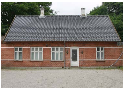
Fig.2. Fotoet fra 2024 viser Ny Højagergårds stuehus set fra gårdsiden. © Roskilde Kommune
