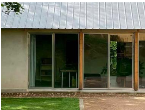
Fig.19. Eksempel på nybyggeri til boligformål, der lægger sig op af traditionelt dansk byggeri fra landet. Bygningens vinduer er af ultra-smalle aluprofiler, hvilket giver bygningen et moderne og let udtryk. © Karlebo landsted
