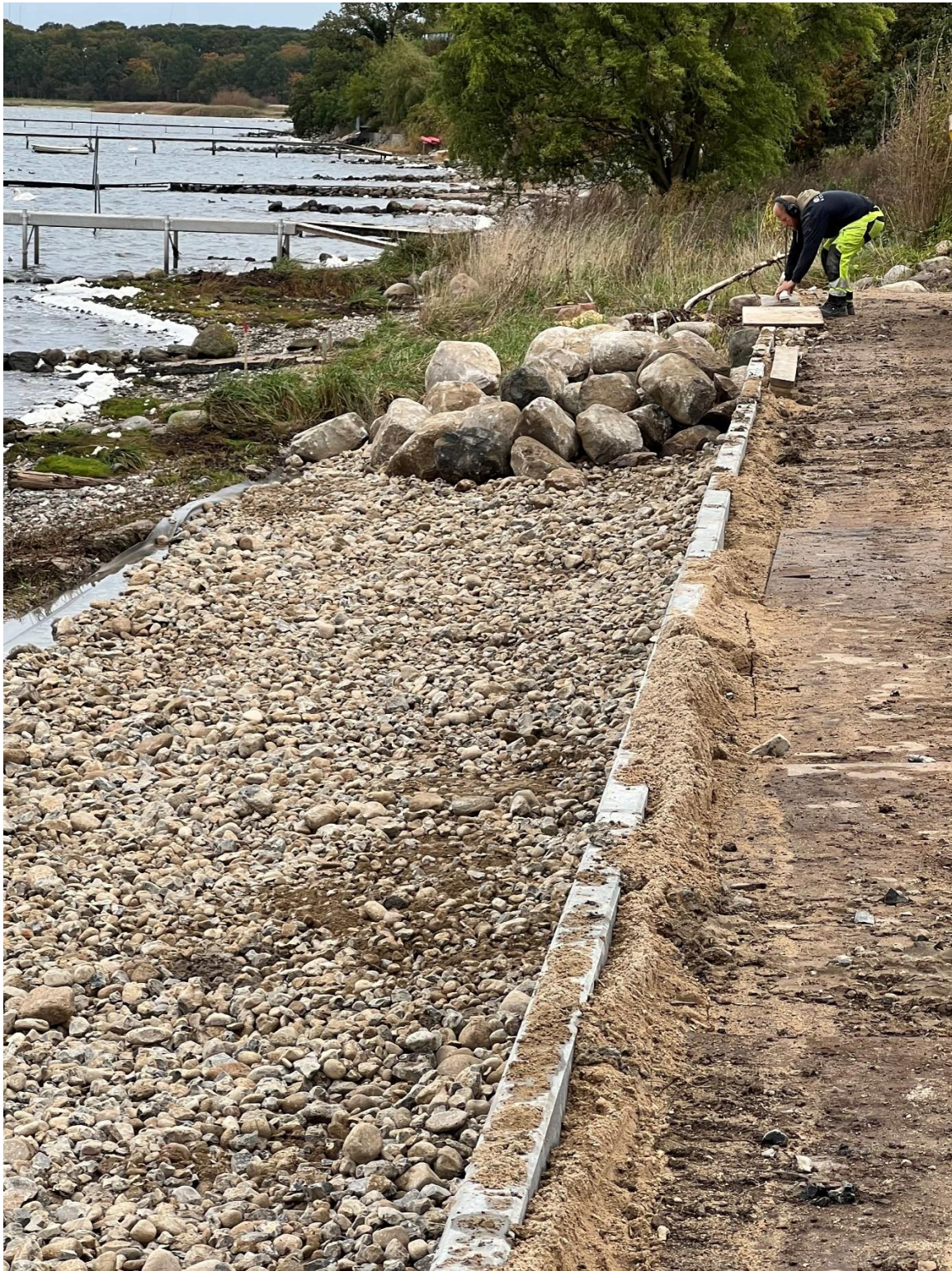
Udlægning af dæksten (>400 mm).
