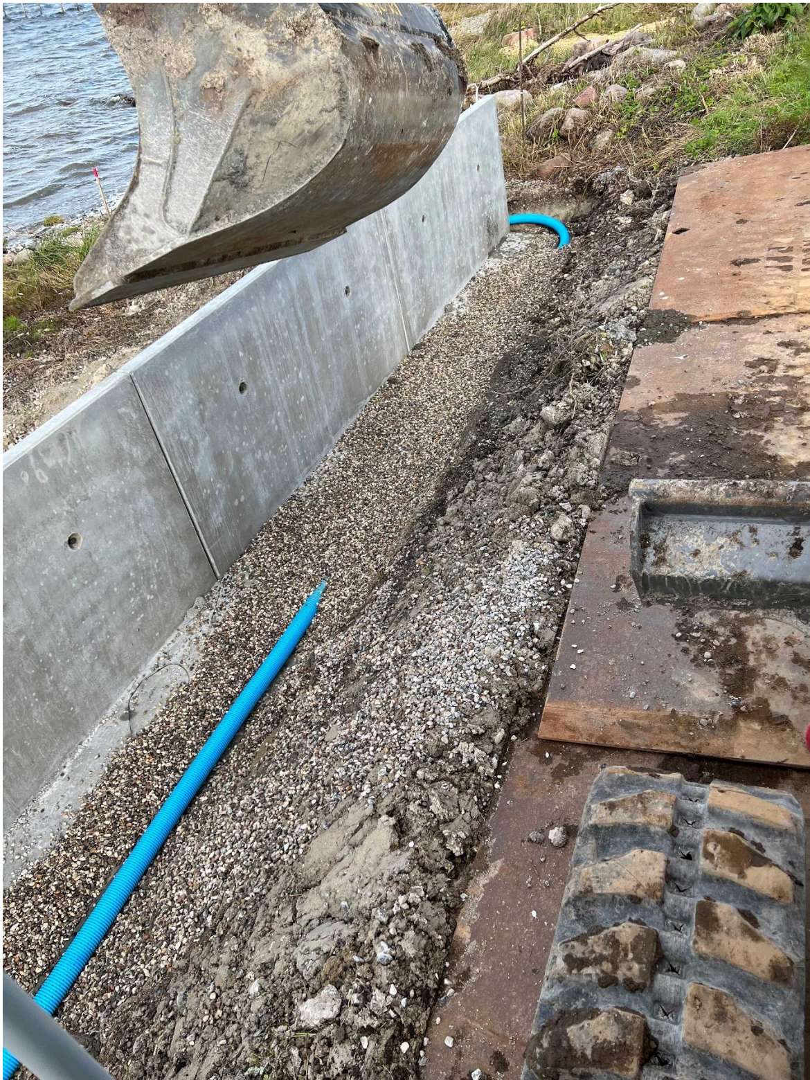
Udlægning af dræn og ærtesten (8-16 mm).
