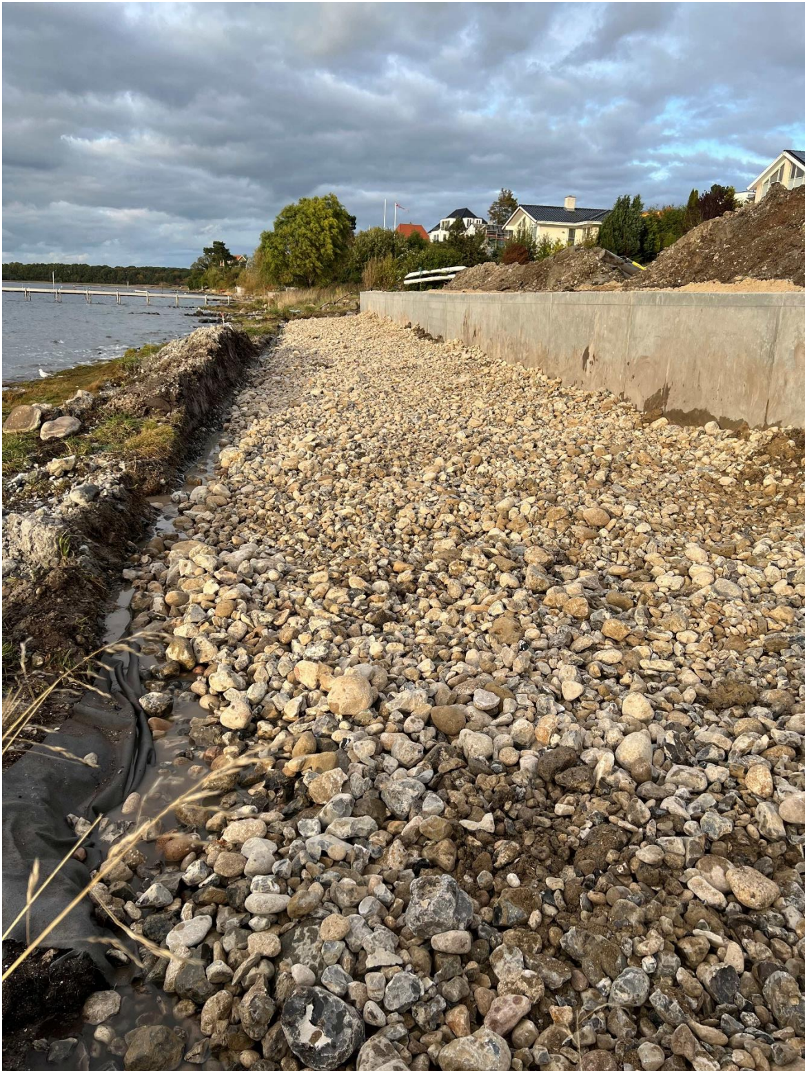
Udlagte filtersten / paksten (64-170 mm).
