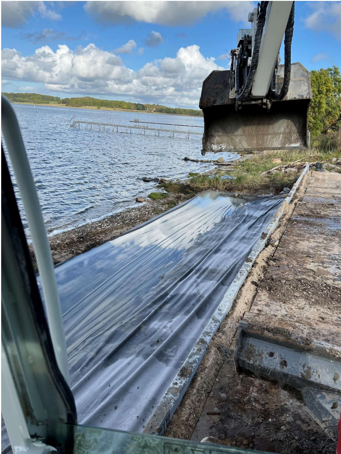
Udlægning af geotekstil.
