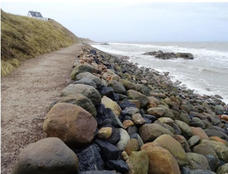
Etableret skråningsbeskyttelse af sten
