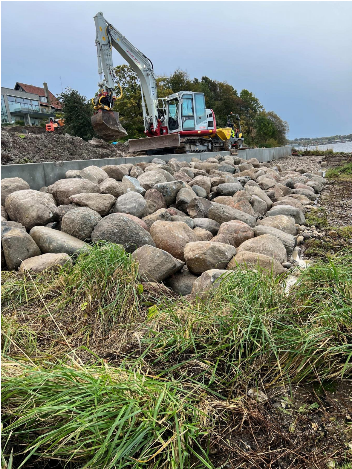
Udlægning af dæksten (>400 mm) på filtersten.
