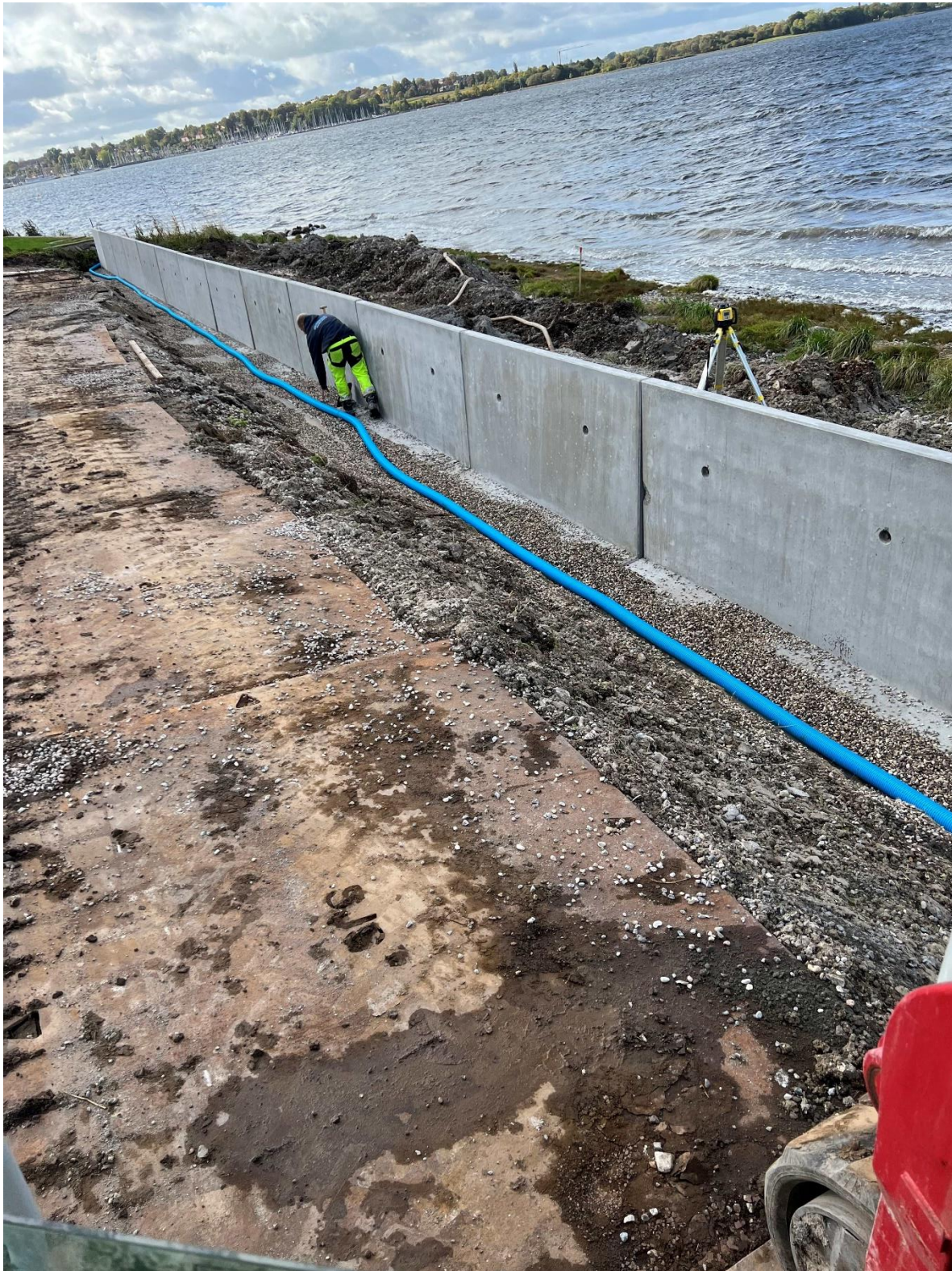
Udlægning af drænledning og ærtesten (8-16 mm).
