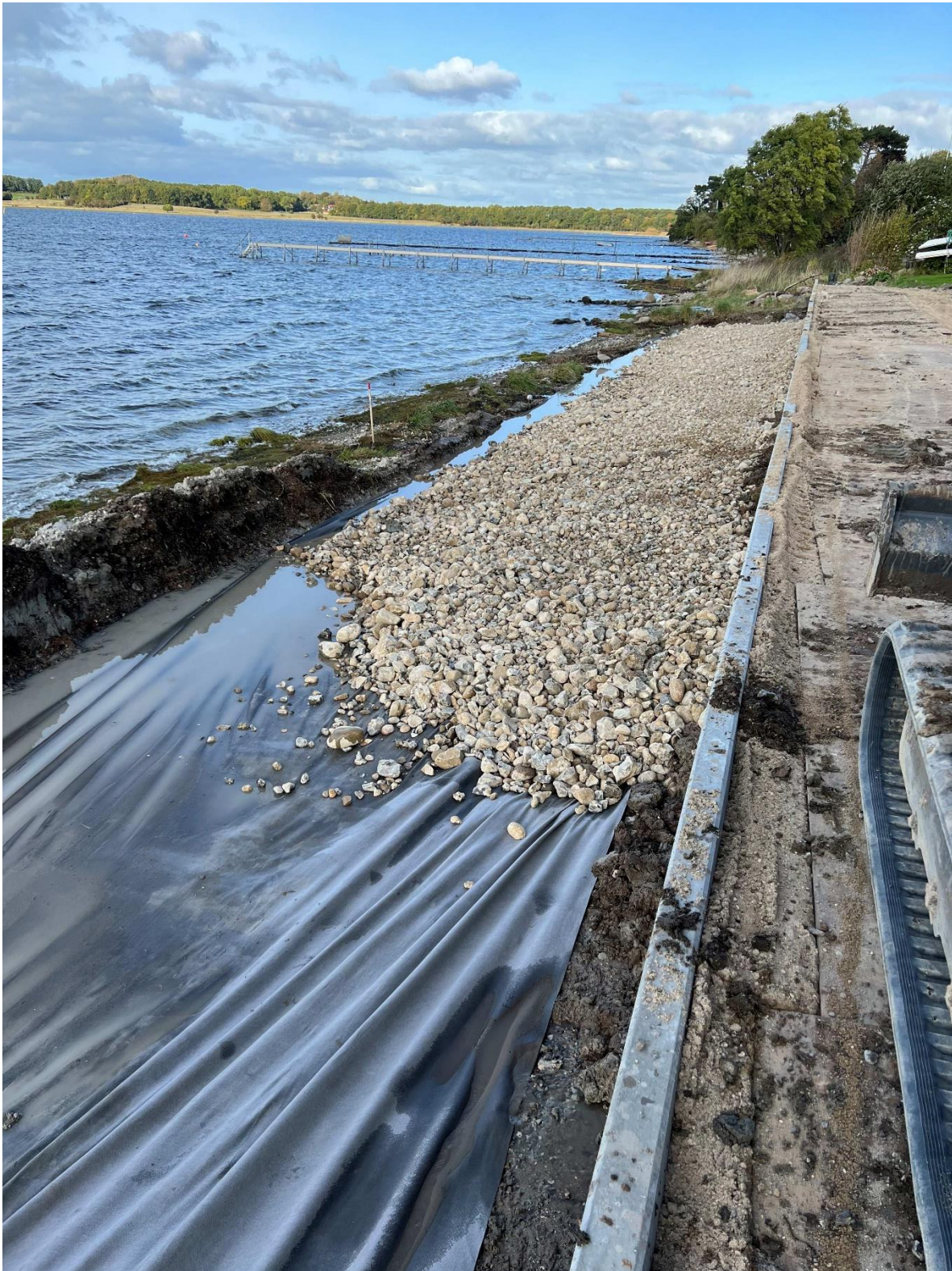
Udlægning af filtersten / paksten (64-170 mm) på geotekstil.
