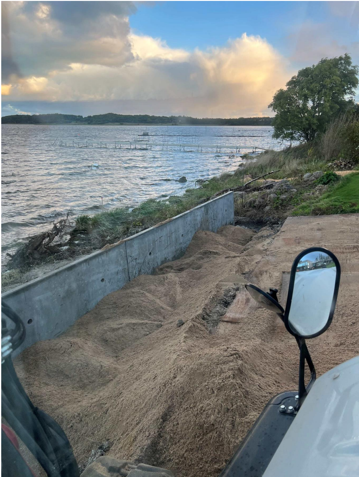
Indbygning af sandfyld.
