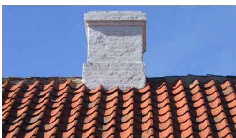
Fig.17. Skorstenspiiben er 'prikken over i'et' på en bygning og ikke mindst taget
