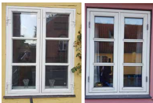
Fig.31. Renoveret vindue og nyt termovindue. Anvendes forsatsruder eller koblede rammer kan de smalle rammer og sprosser bevares
