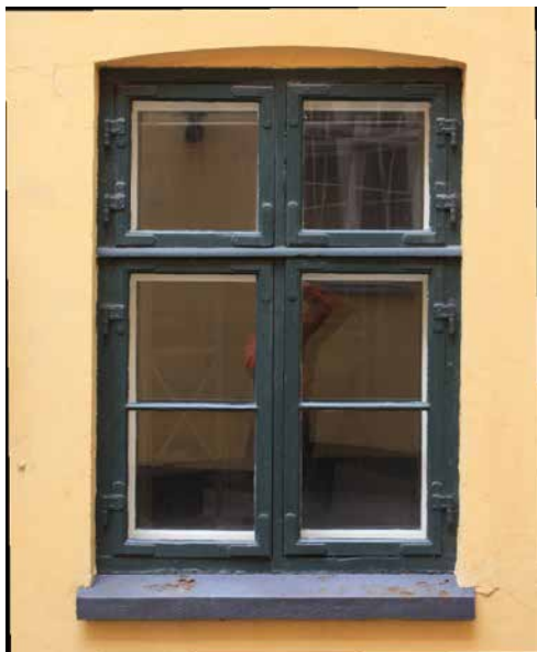
Fig.27. En ældre bygning med vindue eller yderdør i vogngreen passer fint til en gul facade
