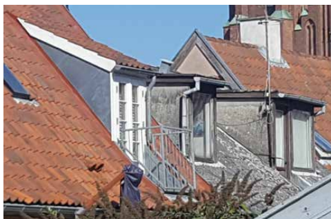
Fig.23. Eksempel på vellykket kvistaltan. Altanen respekterer husets gesims og tagrende og det transparente værn gør den diskret
