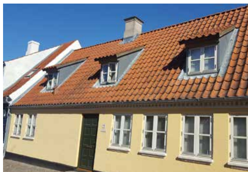
Fig.15. Pultkviste smukt placerede midt i tagfladen. Kvistens front er spinkel, med smalle flunksider og velproportionerede vinduer, der harmonerer med de øvrige vinduer
