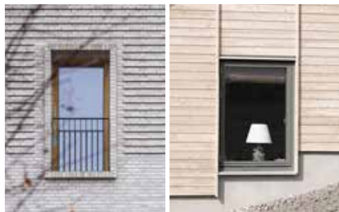
Fig.30. Referencebilleder for detaljeringsprincip for etageboliger og rækkehuse - indramning af vinduer og døre for hhv. facade i tegl og træ.
