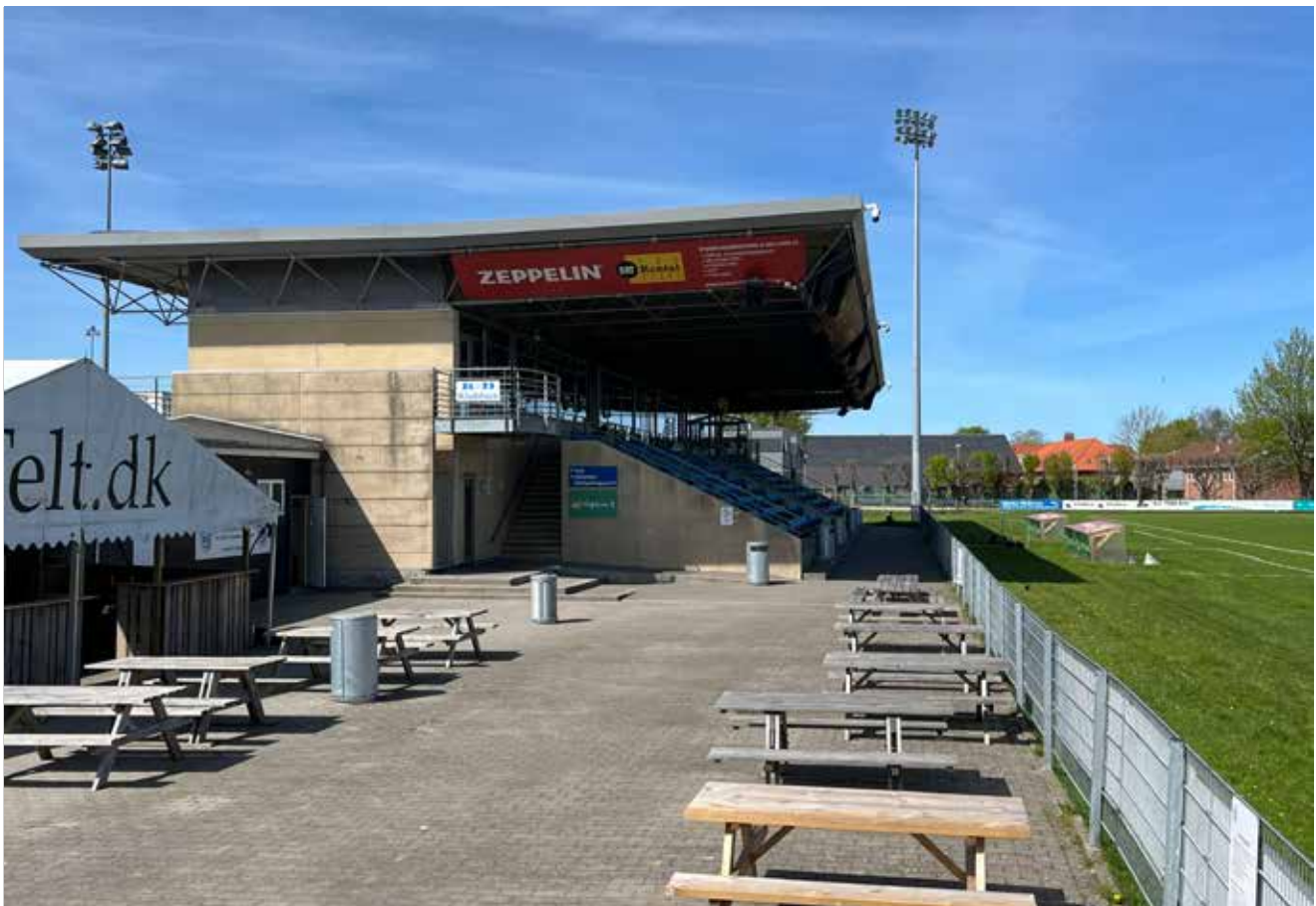
Fig.3. Eksisterende forhold, hovedtribune Roskilde stadion. © SDFE, Roskilde Kommune
