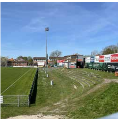
Fig.6. Eksisterende forhold, ståpladser langs stadions østside. © SDFE, Roskilde Kommune
