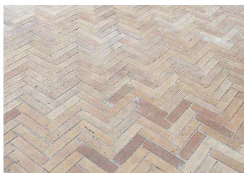
Fig.40. Eksempel på klinkbrændt teglbelægning.
