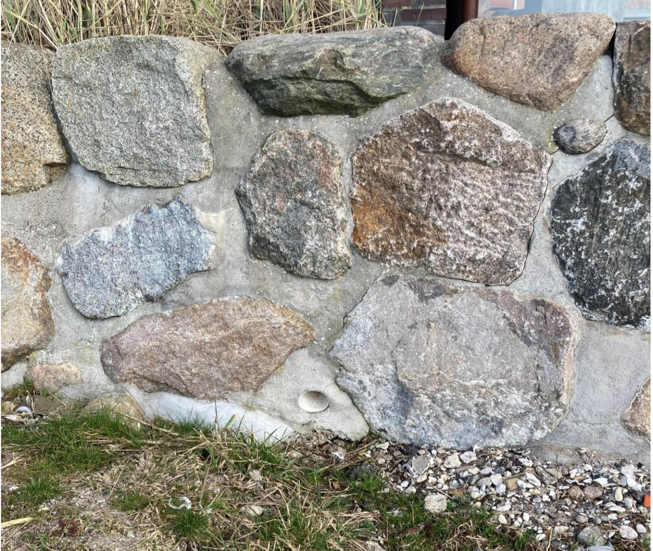
Figur 1.10: Drænrør i den nordlige ende.
