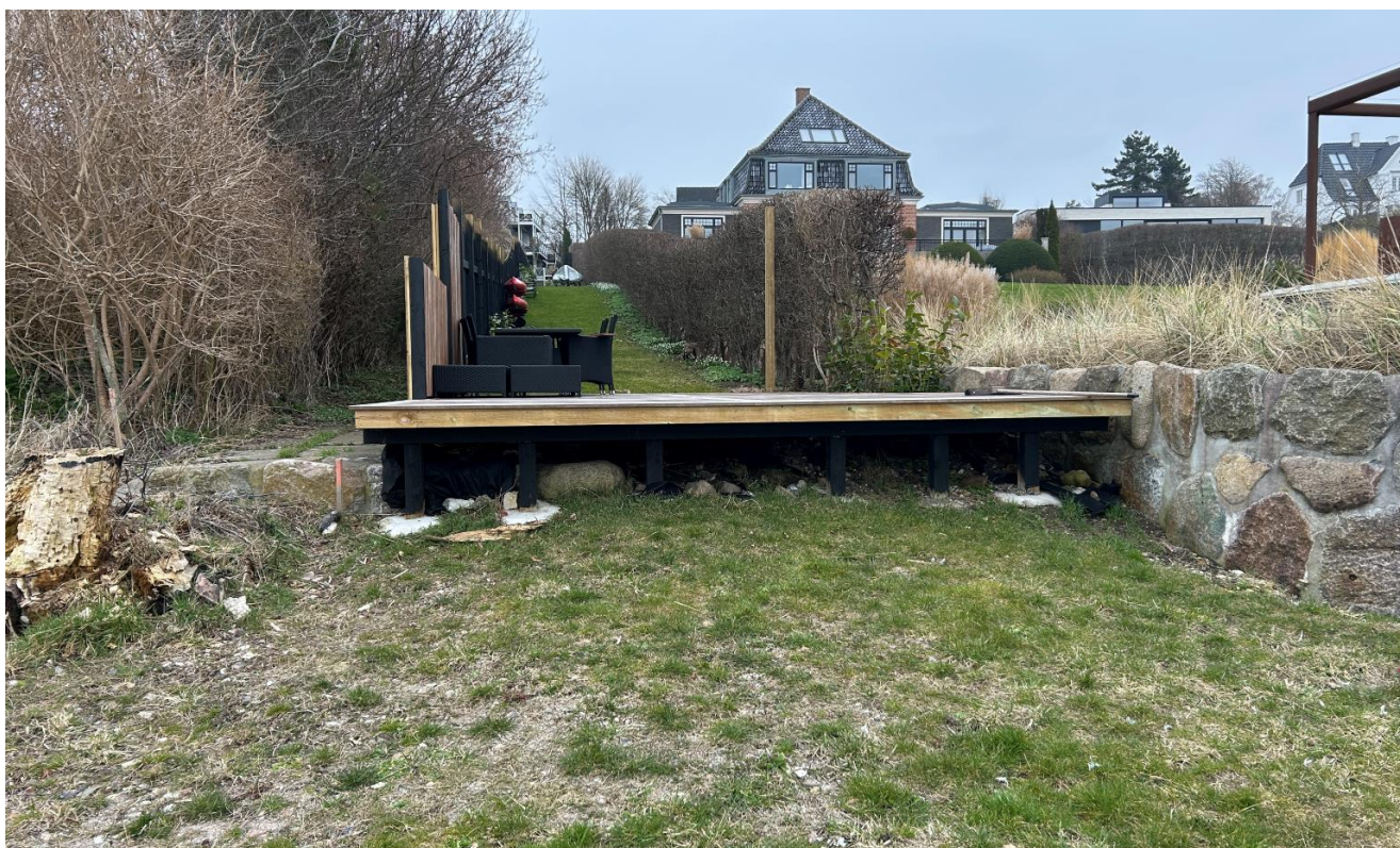
Figur 1.8: Træterrasse ved Frederiksborgvej 121A.
