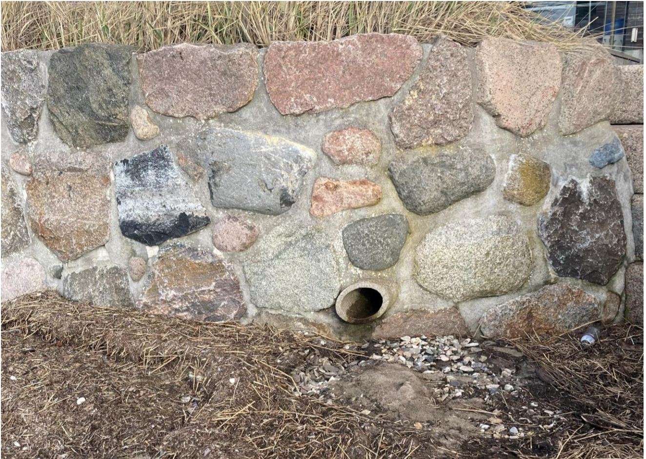
Figur 1.9: Drænrør i den sydlige ende.
