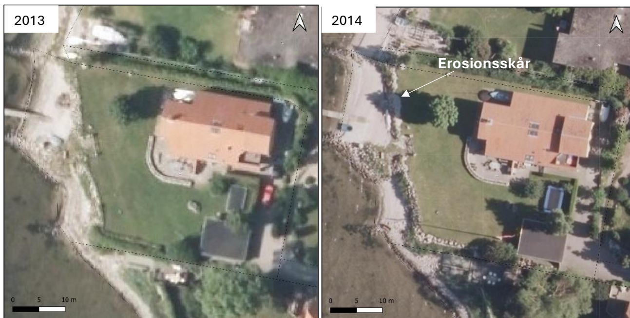
Figur 2.4: Frederiksborgvej 101A, erosion bag skråningsbeskyttelsen efter stormen Bodil i december 2013.
