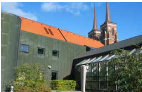
Fig.25. Bygninger med en særlig placering - for eksempel i gård eller på torv, kan opføres i andre materialer. Det kan f.eks. være beton, glas og metal. Her tilbygning til Roskilde Gymnasium.
