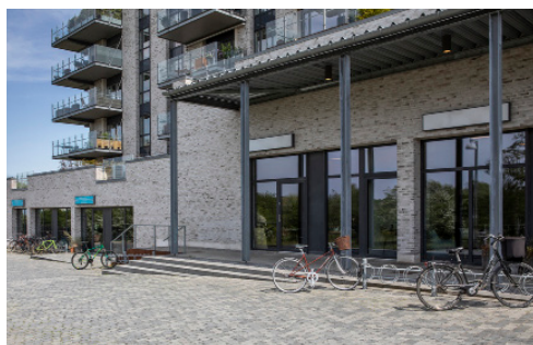
Fig.2. Foto af stueetagen på bygning D langs Akacielunden.
