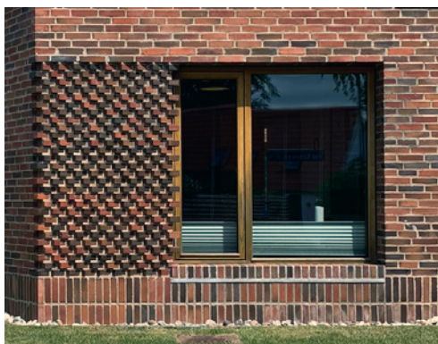
Fig.17. Eksempler på murdetaljer, der tilføjer variation i facadeudtrykket. Fremspring eller tilbagetrækninger skal have en vis dybde. Større dybde kaster mere skygge. Det er i høj grad skyggerne, som skaber reliefvirkning på en facade. Billederne er af Vindinge Sognegård.
