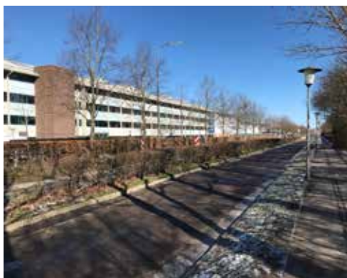
Fig.6. Fotot af eksisterende vej i lokalplanområdet og Æblehaven nr. 74 i baggrunden © Boligselskabet Sjælland
