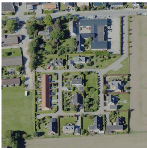
Fig.7. Lokalplanområdet set fra luften, 2021. © SDFE, Roskilde Kommune
