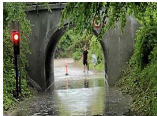
Oversvømmelse af tunnel under jernbanebro i Viby, maj 2018.
