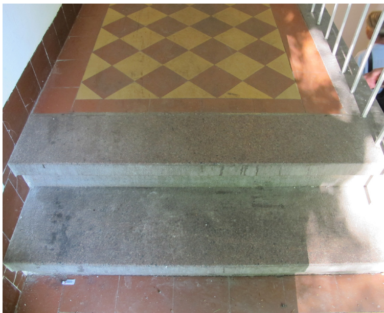
Oprindelig stentræppe indgangen i østfacaden.
