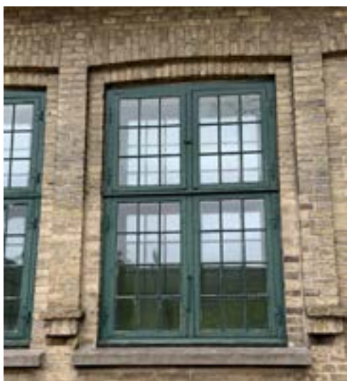
Fig.32. Bygningsdetaljer som døre og vinduer spiller en særlig rolle for helhedsindtrykket på Sankt Hans. Det skyldes dørenes fine profileringer og vinduernes elegante, lette udtryk. Det er vigtigt at bevare området korskpostvinduer med tynde stålsprosser. Ny termovinduer vil give et helt andet udtryk, fordi karme, rammer og sprosser skal være meget kraftigere. Her ses et eksempel på en dør og et vindue på bygning 21 af Kurhus. Kalfatring omkring vinduer bør foretages med hydraulisk mørtel uden cement. De steder, hvor der oprindeligt har været dækningsliste, bør kalfatringen afdækkes med liste malet vogngrøn.
