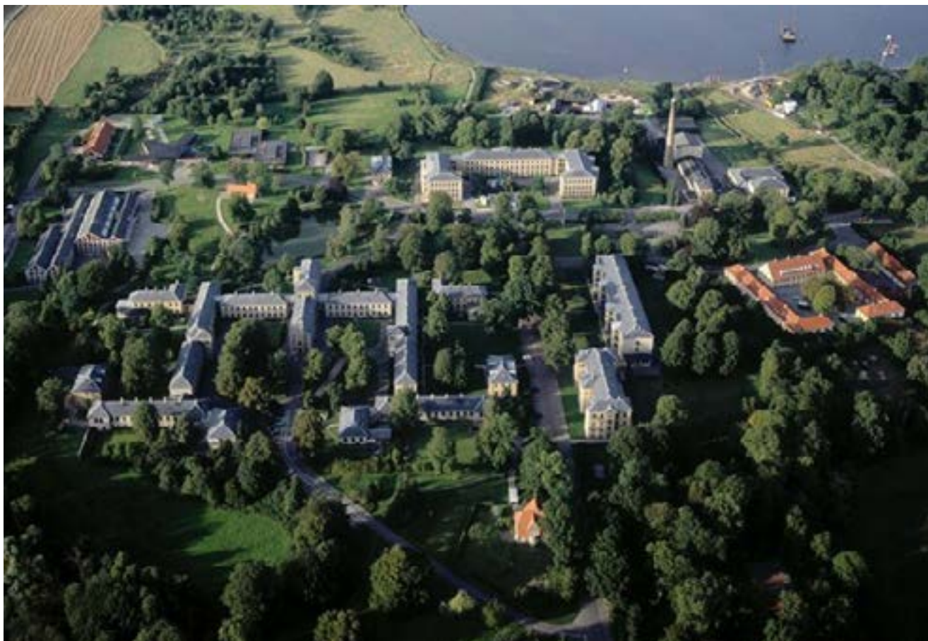
Fig.28. Kurhus, der kom som den første store markante udbygning af området, er i dag fredet, og har med sit historicistiske udtryk lagt rammen for de senere tilføjelser i området, både for direkte appendixer til Kurhus og for de øvrige fritstående bygninger frem til omkring begyndelsen af 1900-tallet. Det indebærer, at det store flertal af de bevaringsværdige bygninger, der helt overordnet set præger billedet i området, er udført i blankt murværk med naturskifer på taget. Slottet, der er den ældste bygning i lokalplanområdet, er dog udført med pudset overflade ligesom nogle få andre bygninger. Nogle af de senere opførte og bevaringsværdige bygninger er opført med tegltage. © Ole Malling
