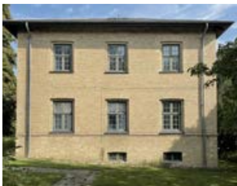
Fig.47. Facade mod vest på Vesterhus.
