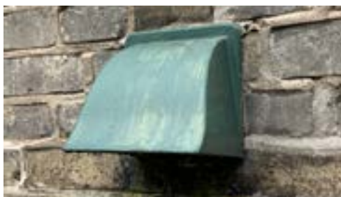
Fig.43. Østerhus' friskluftventiler må ikke fjernes eller ændres.
