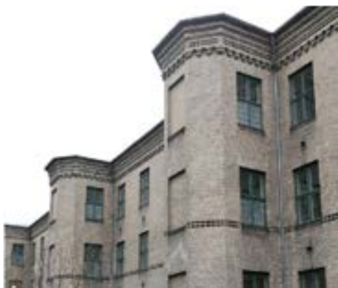
Fig.30. Gennemgående materialer og ornamentering knytter de fleste bevaringsværdige bygninger sammen arkitektonisk. Derfor fastsætter lokalplanens generelle bestemmelser, at facader og gavle skal bevares i blank mur af gule teglsten - altså med synlige teglsten uden overfladebehandling som f.eks. puds og maling. Tage og sålbænkke skal fastholdes i naturskifer. Tagrender og nedløbsrør skal være udført i zink.
