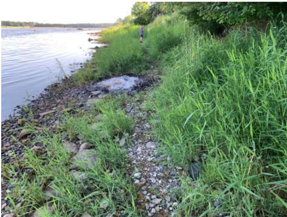
Kysten ved Frederiksborgvej 137, sommer 2021
