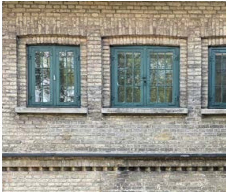
Fig.34. Et smukt facadeudsnit, hvor der er brugt traditionelle håndværksmetoder. Når de bevaringsværdige bygninger skal vedligeholdes og repareres, bør man bruge traditionelle materialer og håndværksmetoder, hvor det er muligt. Ved muråbninger bør der ikke anvendes skårne sten men sten med fulde kanter og formsten. Samlinger, sammenstød og reguleringer i murværket bør ske i fortanding med tilstødende murflader og ikke ved fugning. Når murværk blottes - f.eks. når et trådhegn afmonteres - bør skader på teglsten og fuger udbedres. Ved erstatning af fuger bør der anvendes hydrauliske fuger uden cement.
