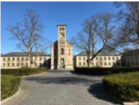
Fig.59. Kurhuspladsen er et eksempel på en formel belægning.
