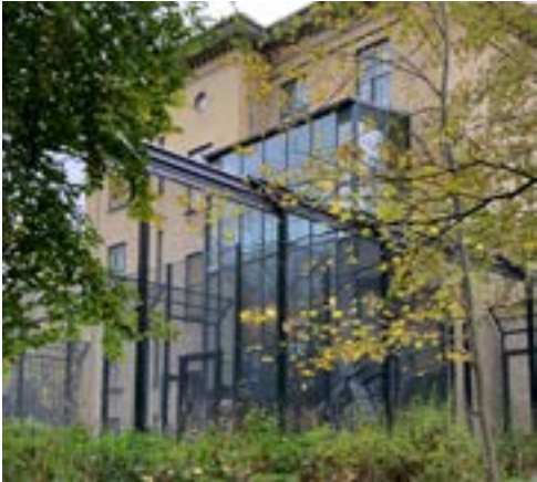
Fig.39. Glastilbygningen og indhegningen på Sønderhus' sydfacade må rives ned og erstattes med vinduer som oprindeligt eller med franske altaner.
