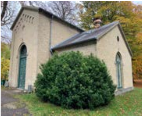
Fig.53. Der må ikke etableres tagvinduer på kapellet. Til gengæld må den rustne udluftningshætte gerne fjernes.
