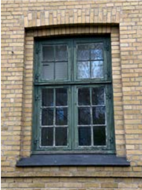
Fig.36. Sankt Hans' farver er med til at binde området sammen. Det gælder især vogngrøn - også kaldet portgrøn, hollandsk grøn og københavnergrøn - der har været en populær farve til bl.a. træværk siden starten af 1700-tallet. Vogngrøn er gennemgående farve på døre, vinduer og bygningsdetaljer på Sankt Hans, og derfor skal farven fastholdes. Lokalplanen fastsætter ikke en bestemt farvekode for farven, der skal anvendes. Det kan f.eks. være NCS-farvekoderne S 8502-G, S 8010-G30Y, 7215-G14Y eller 7116-G37Y. Sort, hvid, rødokker og guldocker er også klassiske farver, der bruges på Sankt Hans. Her kan vælges NCS-farvekoder som f.eks. S 9000-N, 8901-R65B (jernoxidsort), S 9100-N (bensort), S 0300 N, 4544-Y65R (rødokker), S 3060-Y20R (guldocker) og S 1030-Y20R (lys guldocker).
