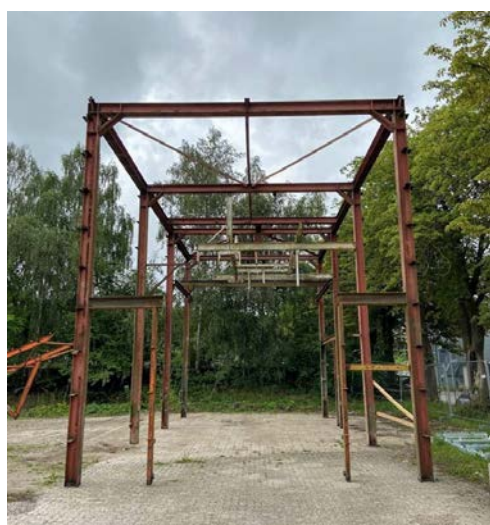
Fig.20. Trappeforløbet kan integreres i de stålkonstruktioner, der tidligere har udgjort tårnet til Hal 12. Tårnet udgøres af to stålkonstruktioner, hvor den ene ses her.
