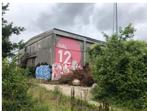
Fig.23. Hal 12 fremstår i dag med fremskudte søjler og bjælker i beton og tilbagetrukne facadepartier (fag). Facadepartierne kan udskiftes, mens de bærende konstruktioner skal bevares.
